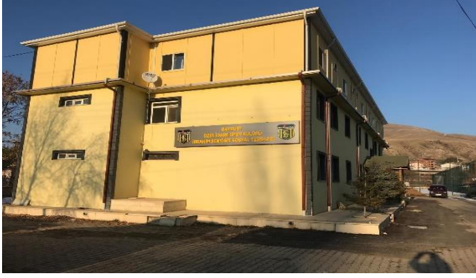
Şekil 4.174. Bayburt Özel İdare Sporun Yeni İnşa Edilen Tesisi
