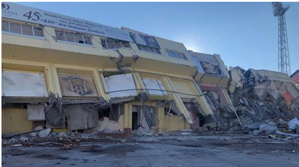
Şekil 4.104: Malatya İnönü Stadı Yıkım İşlemleri (Özgür Karataş Arşivi)
