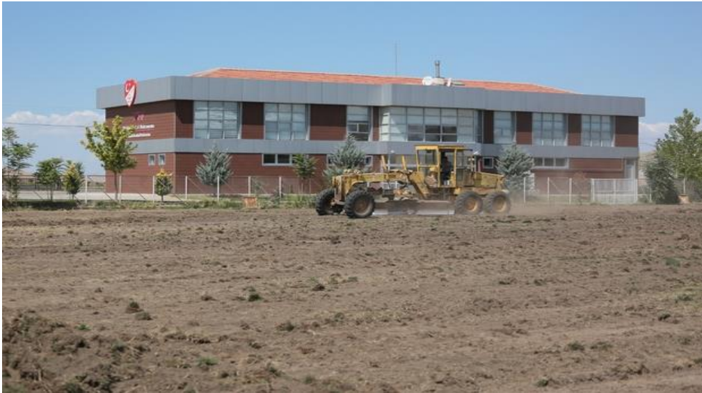
Şekil 4.100: Yeni Malatya Spor Kulübü Futbol Köyü Projesi Çalışmaları (115)
