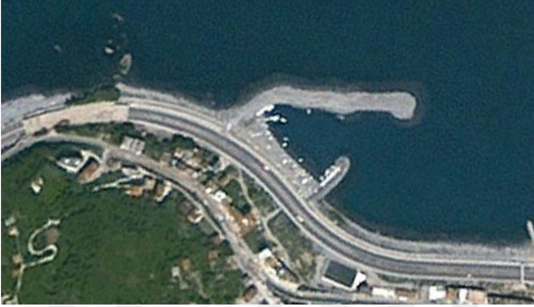
Şekil 2.5: Pazar Soğuksu balıkçı barınağı genel görünümü.
