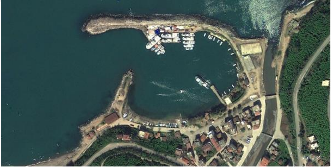
Şekil 2.2: Yalıköy balıkçı barınağı genel görünümü.
