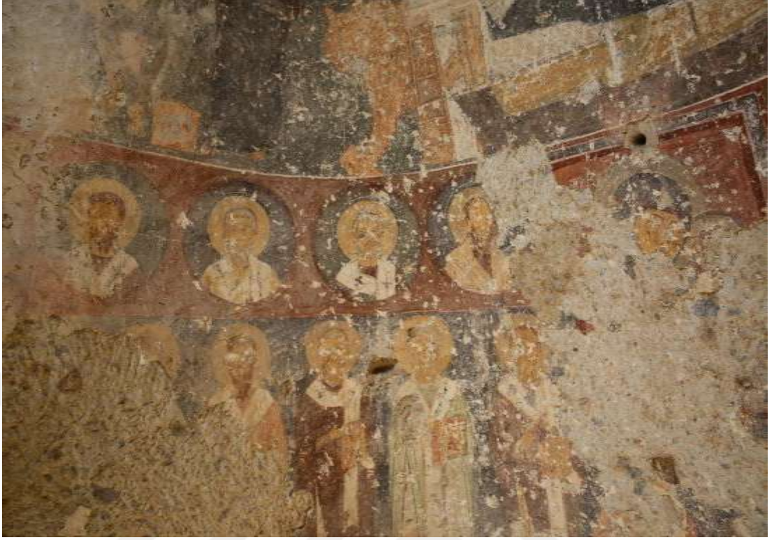
Foto. 114- Erdemli Kilise Camii, apsis duvarı, detay. (M. Gülyaz arşivinden)
