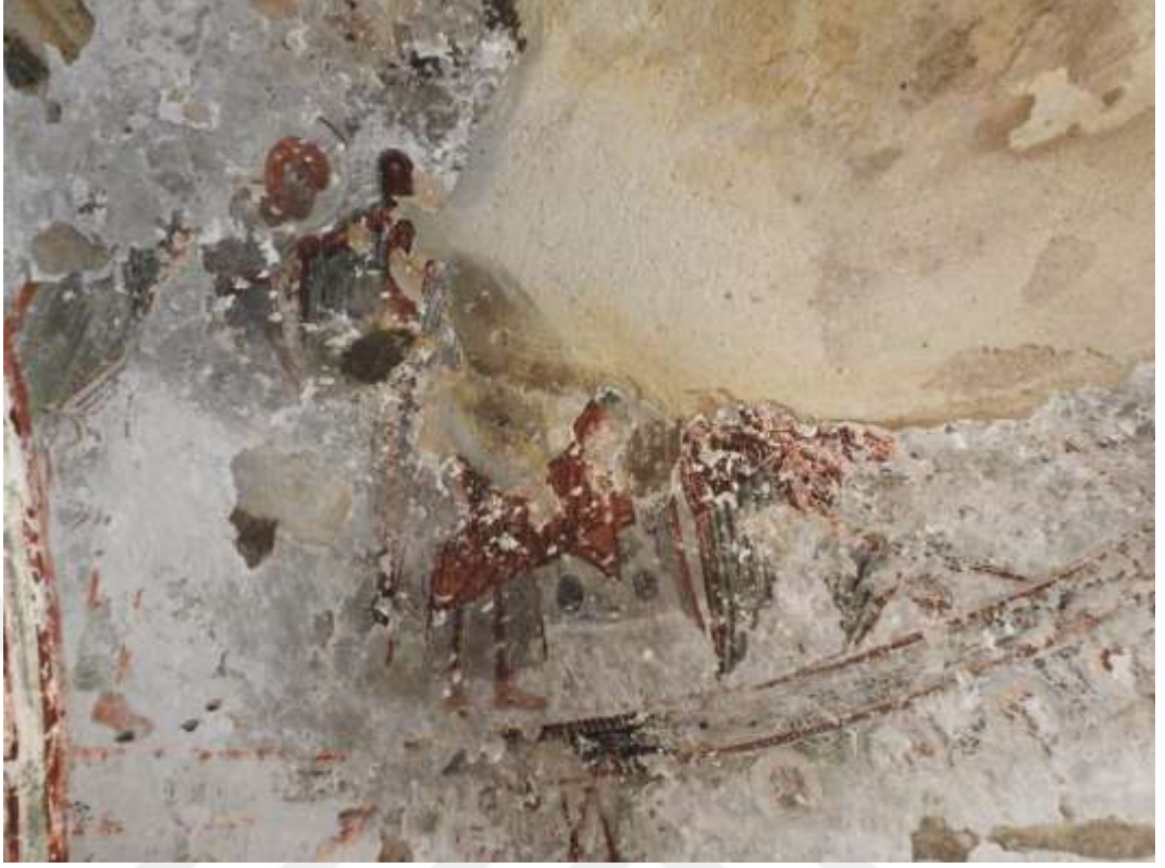
Foto. 17- Vaftizci Yahya Kilisesi, apsis yarım kubbesi, kuzey.
