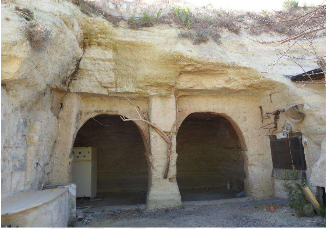
Foto. 45- Göreme Kilise No 3, nefin olduđu yerden güneye bakış.
