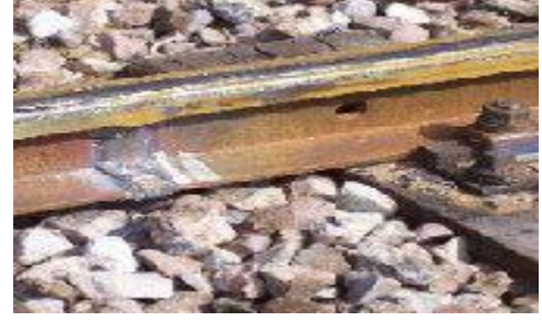
Şekil 1.18: Alümina termit kaynağı
