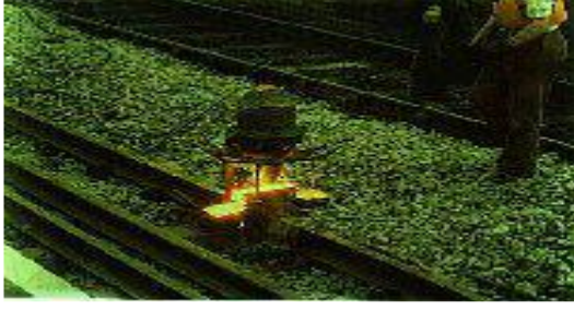
Şekil 1.18: Alümina termit kaynağı
