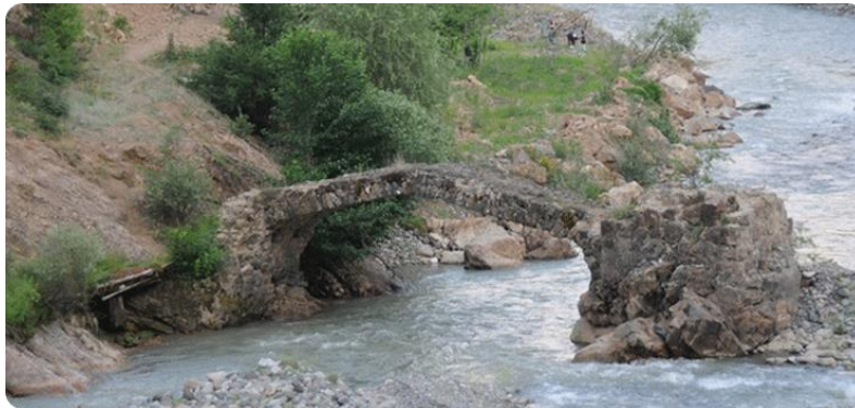
Şekil 3.12: Meydancık taş kemer köprüsü (Şavşat Belediyesi, 2017a)
