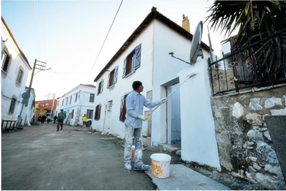
Şekil 4.5: Belediye tarafından yapılan yenileme çalışmaları (İzmir Belediyesi, 2014)
