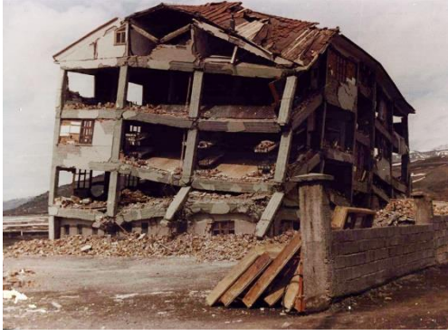
Şekil 2.5 : Erzincan Depreminin Yapılarda Meydana Getirdiği Hasar [17].
