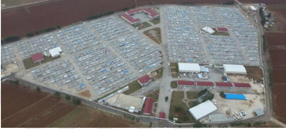
Şekil 4.179 : Şanlıurfa Harran Konteyner Kenti [51].
