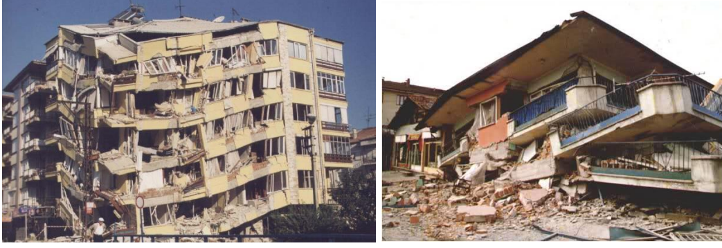
Şekil 2.7 : Dinar Depremi Sonrası Hasar Gören Yapılar [19], [20].
