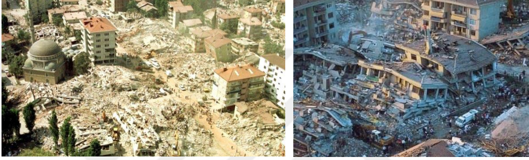
Şekil 2.9 : Gölcük Depreminin Meydana Getirdiği Yıkım [24], [25].
