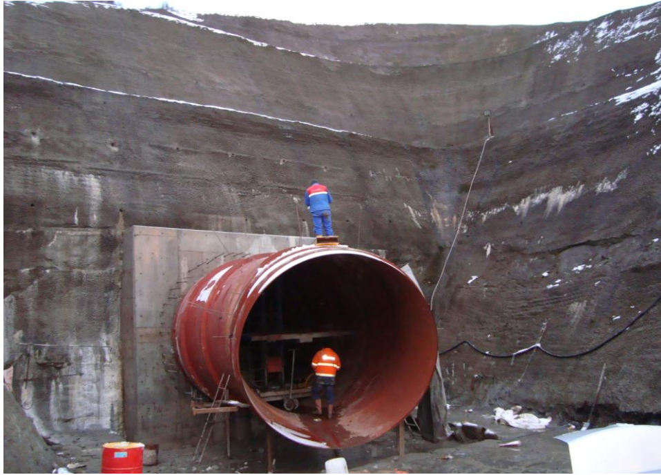
Şekil 7.8. Çekim yapılacak kaynaklı borunun görünümü.
