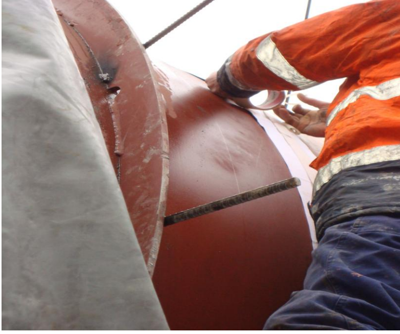
Şekil 7.13. Radyografik film üzerine elastik bant sarılması.
