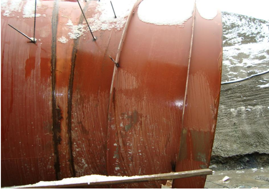
Şekil 7.9. Çekim yapılacak kaynaklı borunun kaynağının görünümü.
