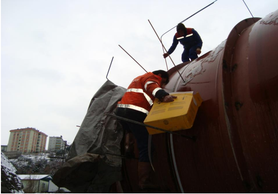
Şekil 7.10. Kurşun ekran içindeki radyografik filmin kaynak üzerine yerleşimi.
