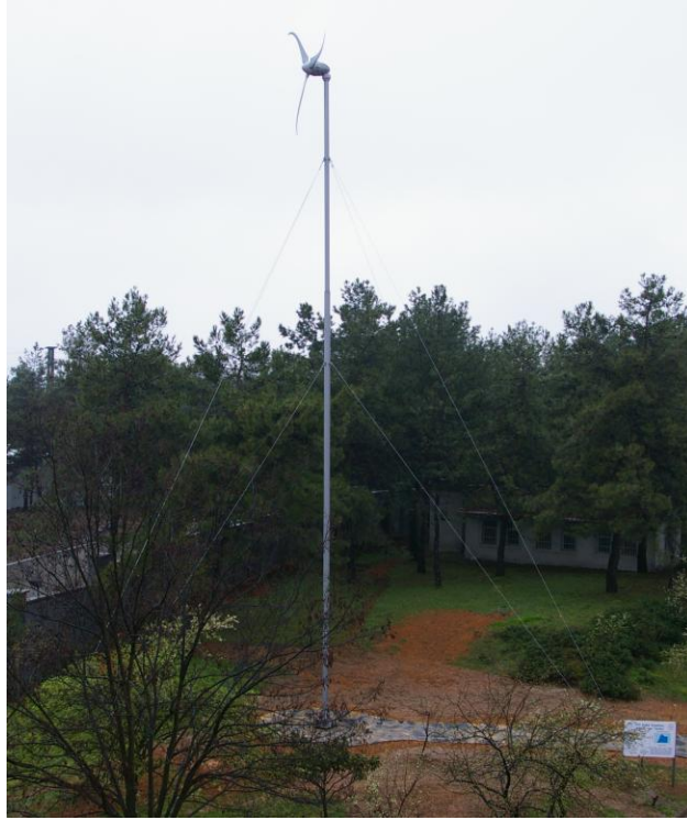
Şekil 5.1 İ.T.Ü RT-1 Skystream 3.7 rüzgar türbini
