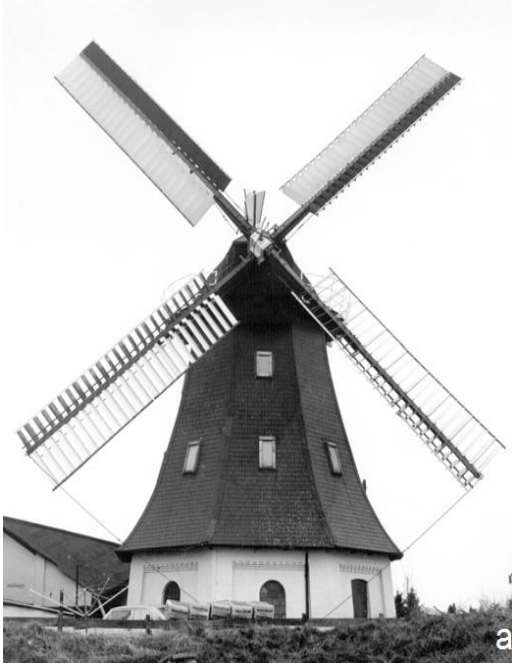
Şekil 1.5 : a-Klasik yel değirmeni(Hau, 2006); b-Yavaş rüzgar türbini (Hau, 2006)
