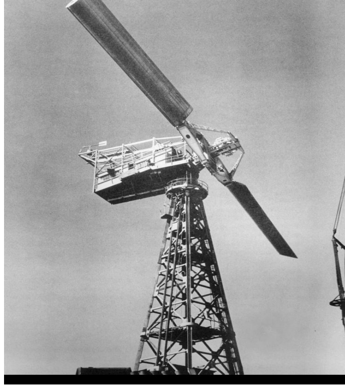
Şekil 1.2 : Smith-Putnam rüzgar türbini Vermont, Amerika, (Rotor çapı 53.3 m, anma gücü 1250kW)(Hau, 2006)
