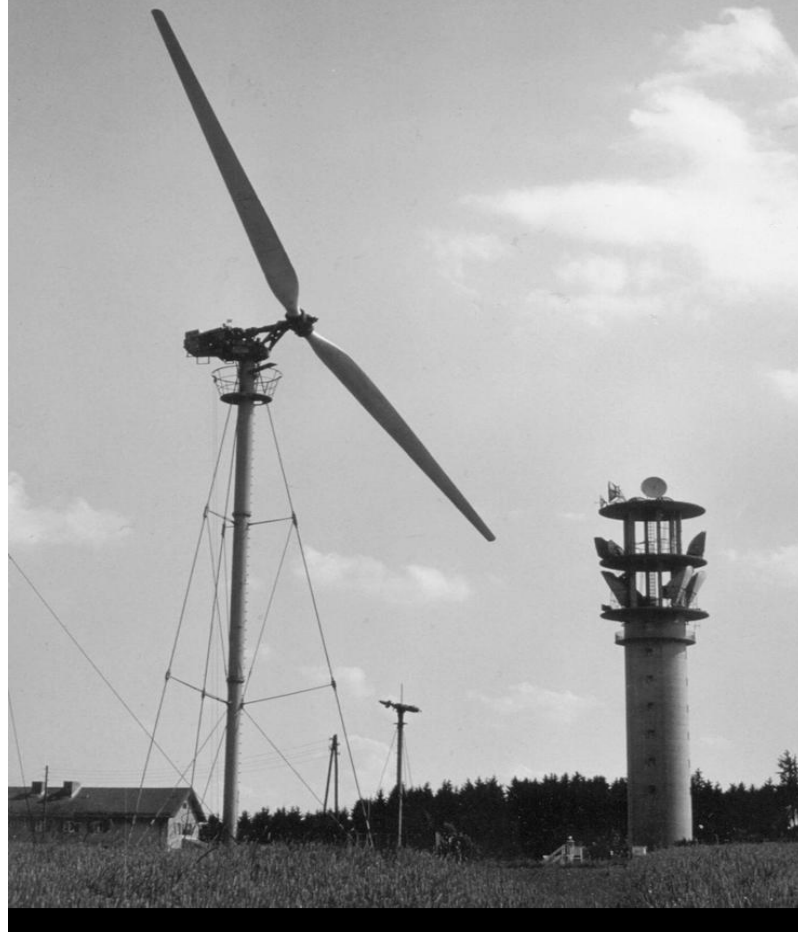
Şekil 1.3 : U. Hütter W-34 rüzgar türbini Stötten, Almanya (Rotor çapı 34 m, anma gücü 100kW) (Hau, 2006)
