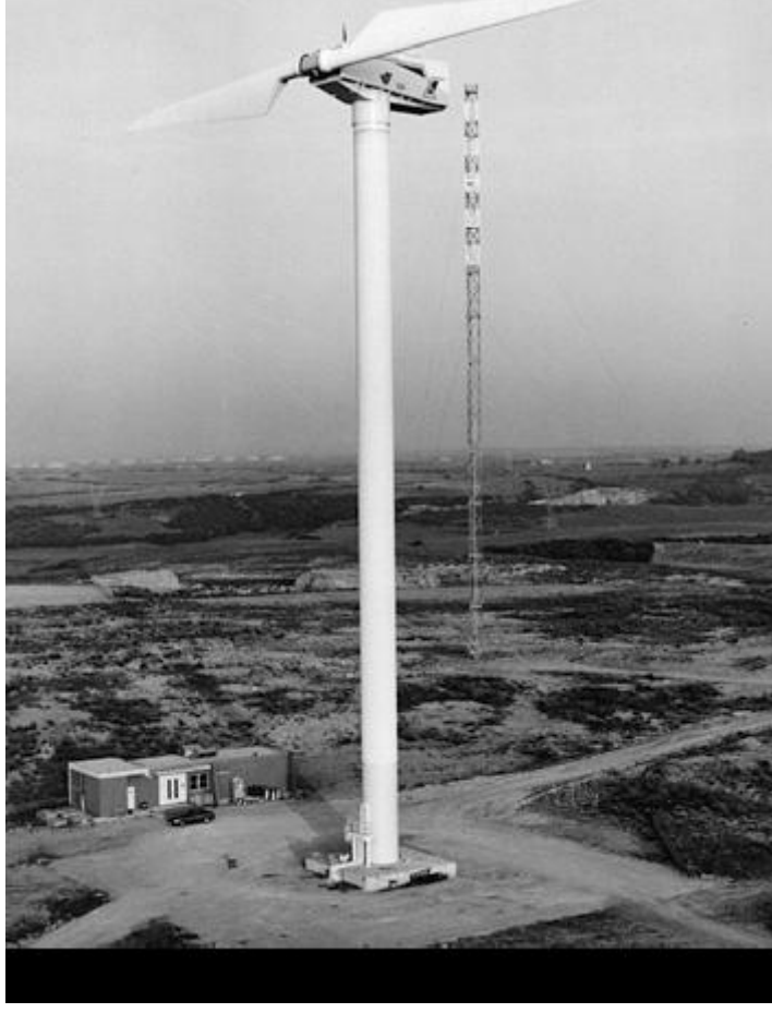
Şekil 1.9 : İki kanatlı türbin (Hau, 2006)
