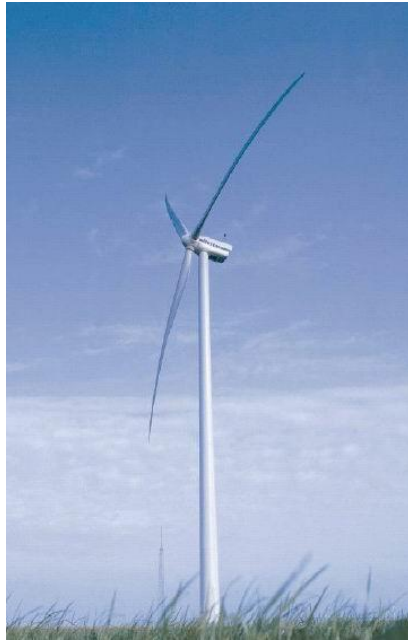
Şekil 3.4 : Üç kanatlı yatay eksenli modern rüzgar türbini.
