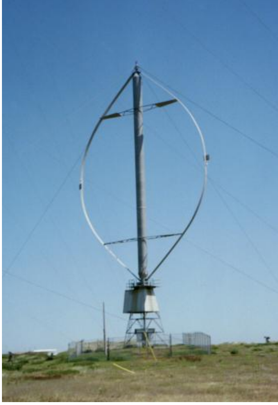
Şekil 3.5 : Darrieus tipi rüzgar türbini.
