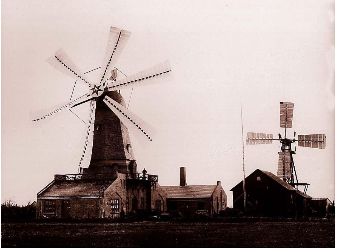
Şekil 3.1 : Poul la Cour'un test türbinleri.
