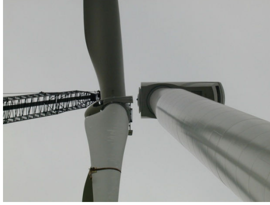
Şekil 4.9: Türbin hub ve kanatların montajı
