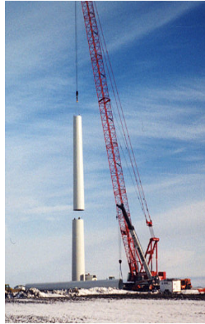
Şekil 4.8: Türbin kule montajı
