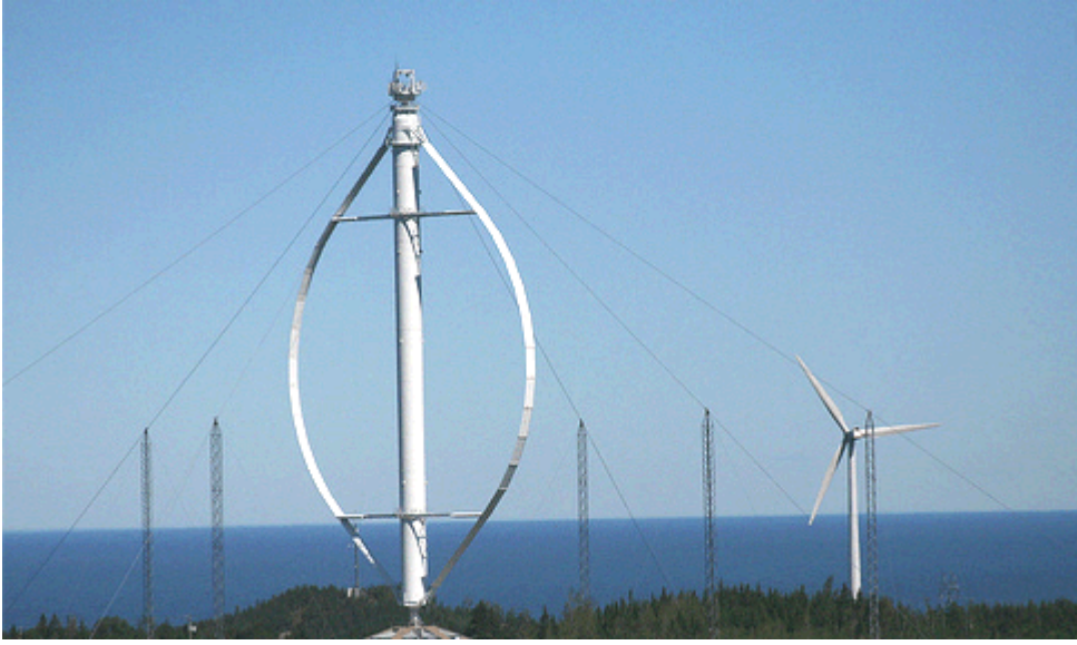
Şekil 3.1: Dikey eksenli bir rüzgar türbini.
