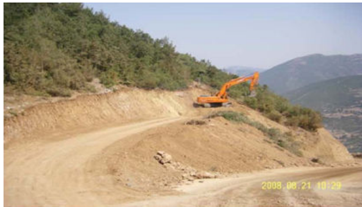
Şekil 4.5: Servis yolu inşaatı.
