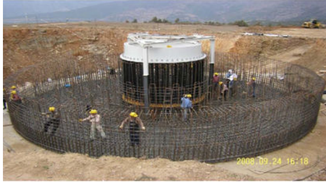
Şekil 4.6: Rüzgar türbinini temel yapımı.
