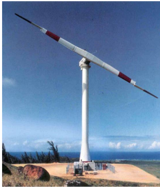
Şekil 2.7 : İki kanatlı rüzgar türbini (NASA/DOE Mod-5B) Hawaii ABD (URL-1).
