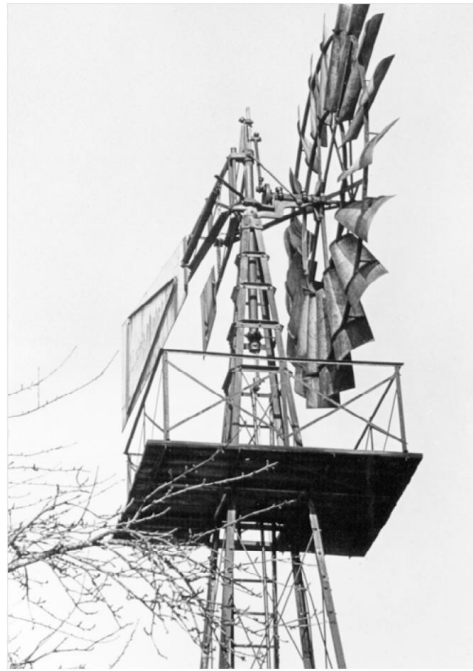
Şekil 2.2 : “Eklis” dizayn Amerikan rüzgar türbini (Deutches Museum) (Hau,2006).
