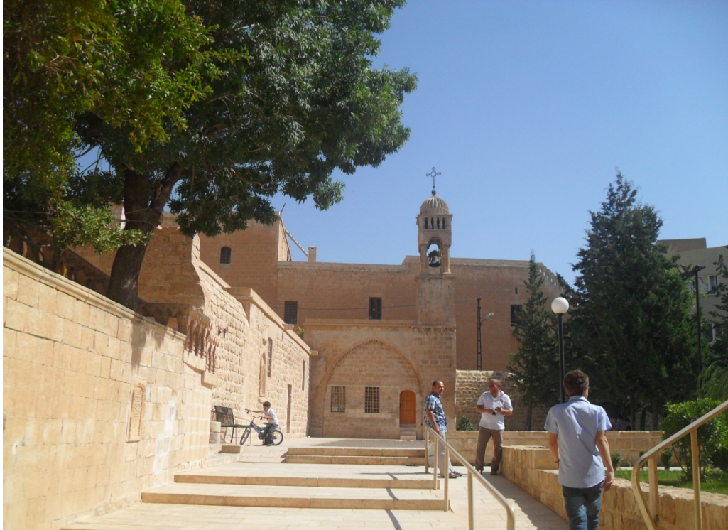
Şekil 57 Antakya Süryani Ortodoks Kilisesi Kilisenin Dış Kısmı
