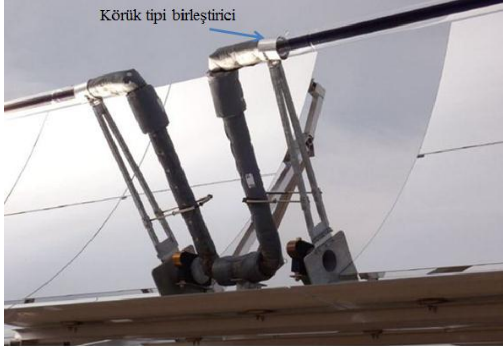
Şekil 4.12: Körük tipi birleştirici [77].
