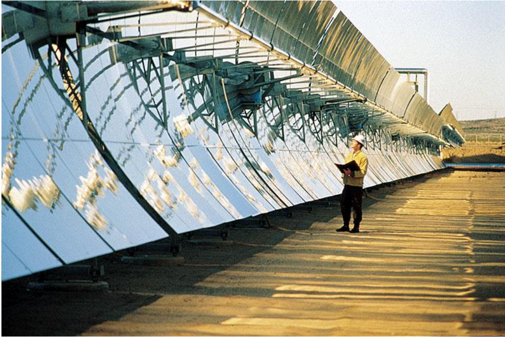
Şekil 1.8: Parabolik oluk tipi güneş enerji sistemi [9].
