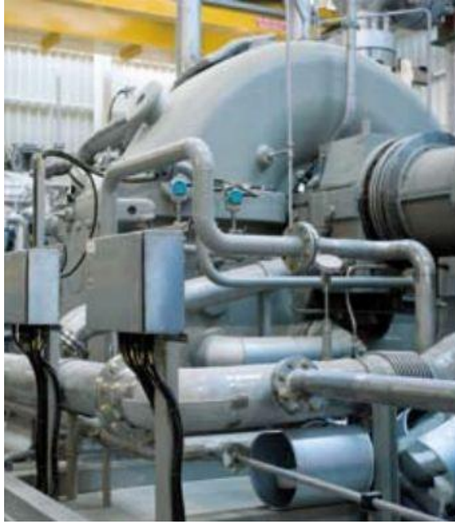
Şekil 2.13: Buhar türbini [35].
