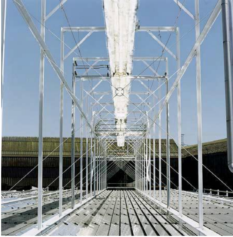
Şekil 1.9: Fresnel tipi güneş enerjisi sistemi [11].
