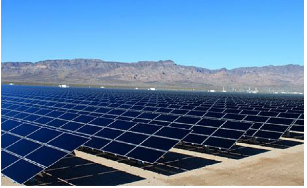
Şekil 1.12: Fotovoltaik panel uygulamaları [17].
