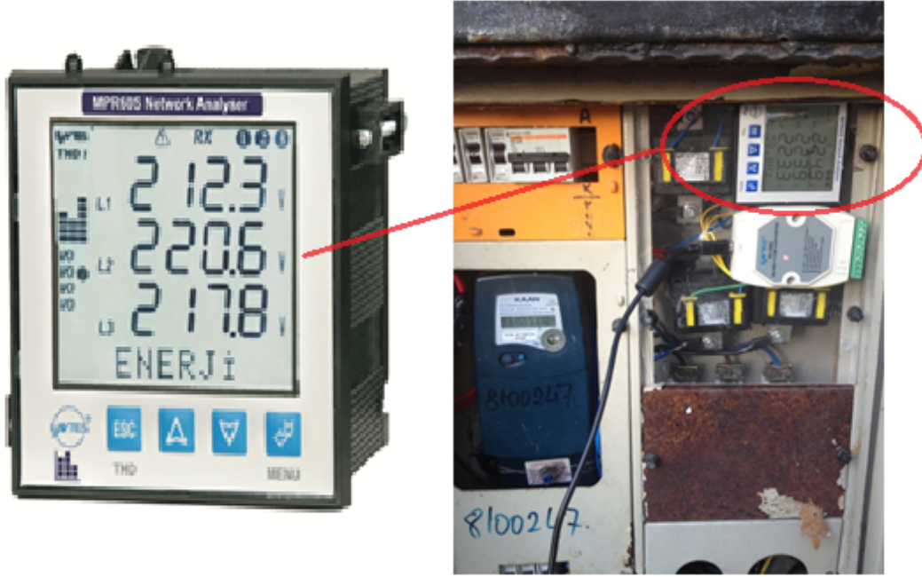
Şekil 4.2 : Cihazın genel görüntüsü ve pilot ev uygulama resmi.
