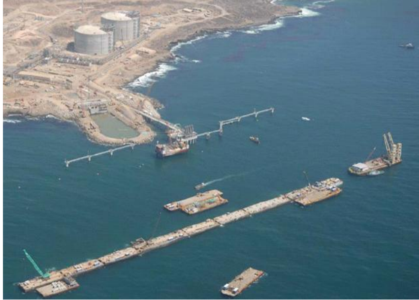
Şekil 5.7: Dalgakıran kullanılarak yapımı gerçekleştirilen bir onshore terminal (Sonne and Bomba , 2008)
