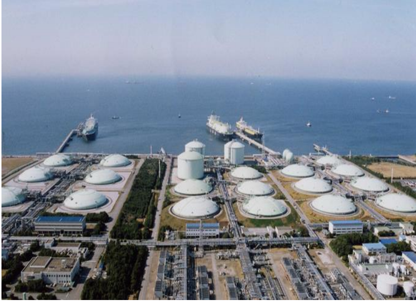
Şekil 5.8: Yer altı depolamanın yapıldığı bir LNG terminali (Url-17)
