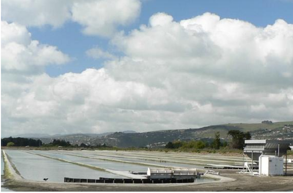
Şekil 5.7 : Christchurch atık su arıtma tesisinde bir su kanallı havuz, Yeni Zelanda [92].
