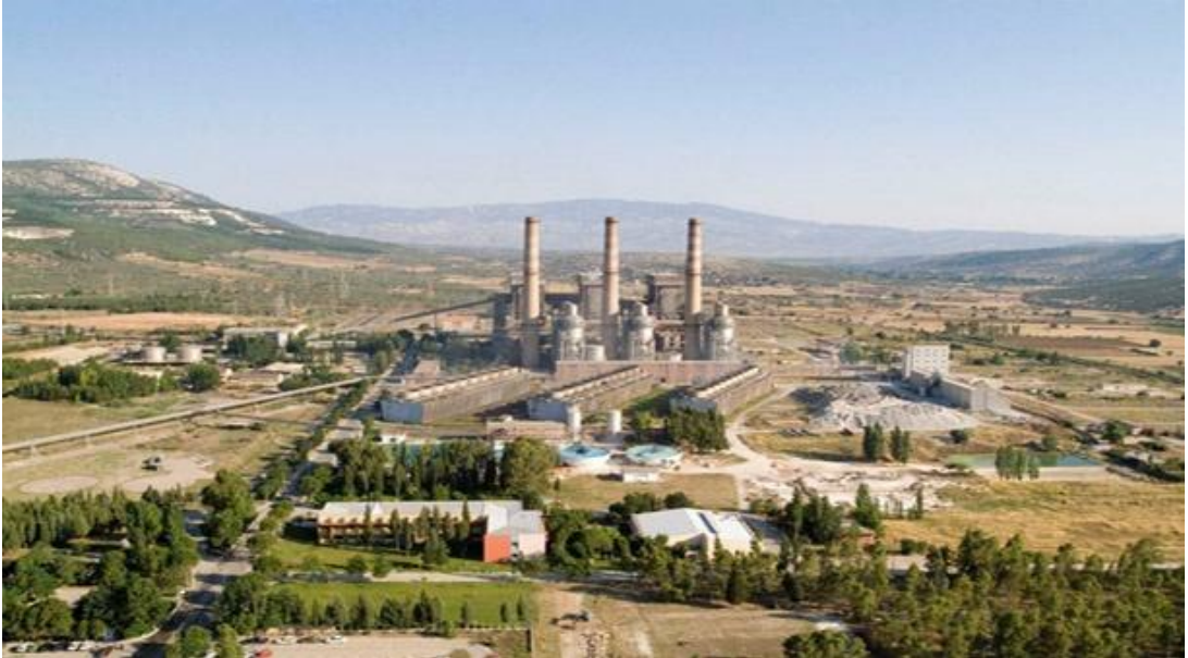
Şekil 7.1 : Yatağan Termik Santrali [111].
