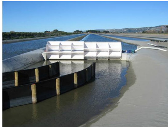
Şekil 5.9 : Christchurch atık su arıtımı havuzunda kullanılan su arkı [92].
