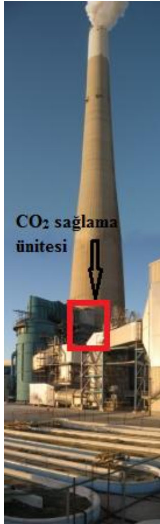
Şekil 1.4 : Seabiotic tesisinde CO 2 kaynağı olan termik santral bacası ve üzerindeki ünite [10].
