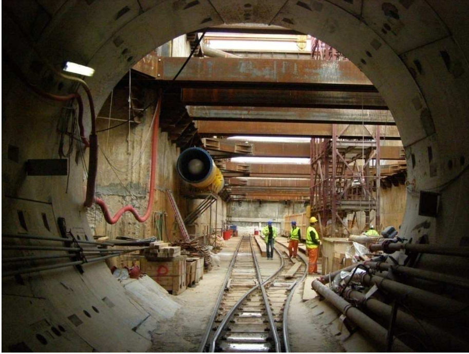
Şekil 2.6 Selanik metro inşaatı
