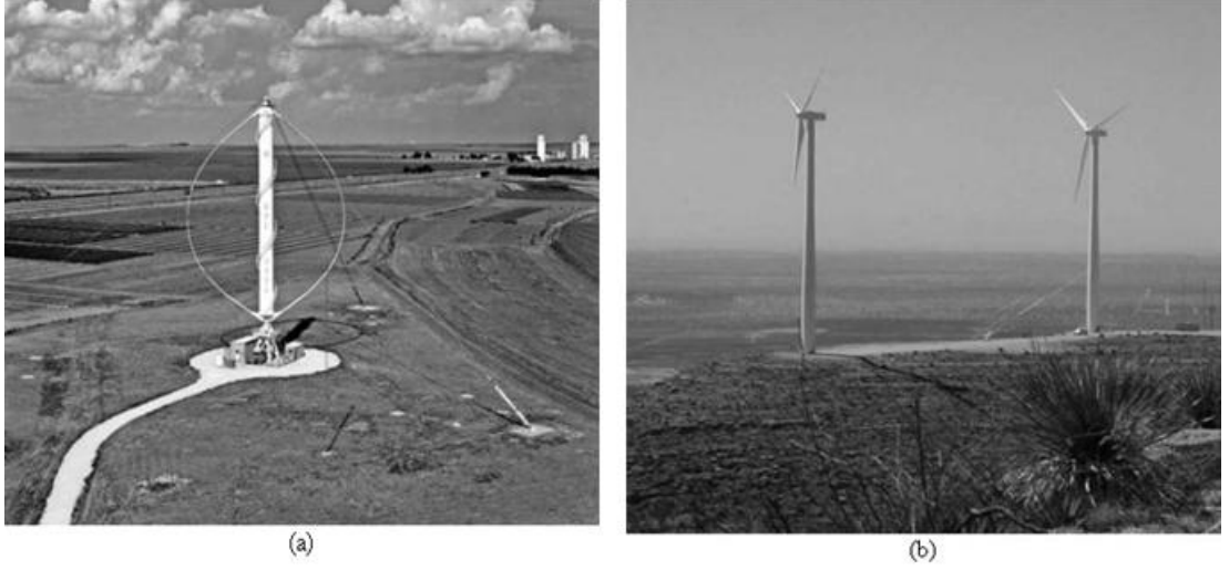
Şekil 2.1 : (a) Dikey eksenli (b) yatay eksenli rüzgar türbini [6].
