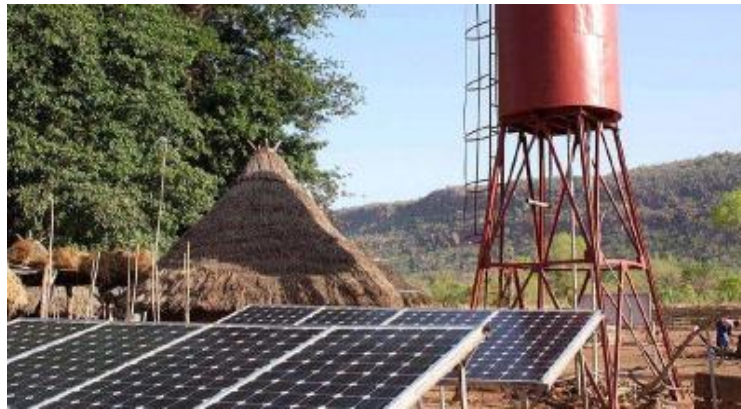
Şekil 3.4: Fotovoltaik destekli ve depolu su pompalama sistemi [24].
