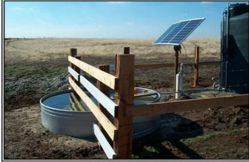
Şekil 3.20: Depolama tanklı fotovoltaik sistemli sulama [40].
