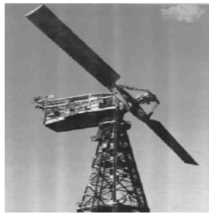
Şekil 1.3 : Putnam rüzgar türbini 1.250 kW - 1941 ABD.[9]
