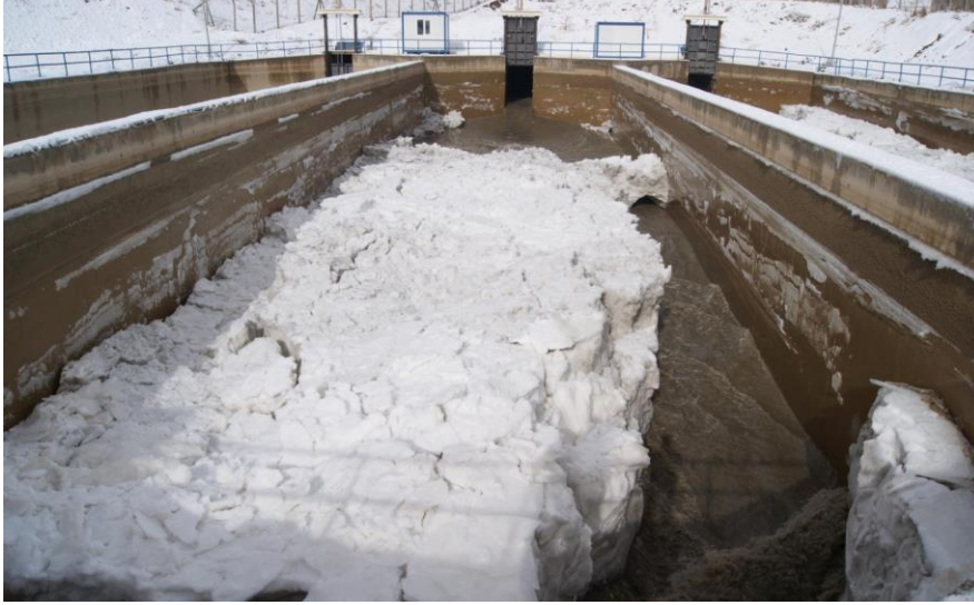
Şekil 6.38: Çalışmalar sonucu su akışı sağlanan çökeltim havuzu
