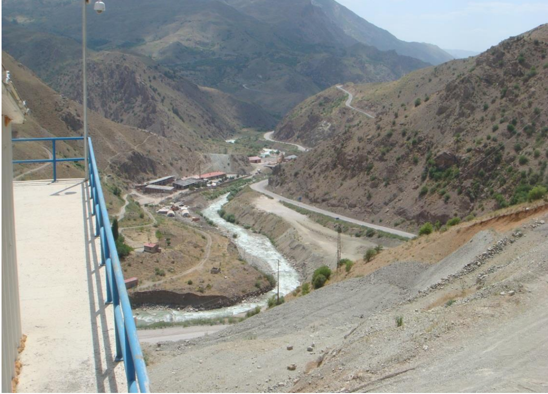
Şekil 6.2: Van-Hakkari karayolu ve Zap suyu görünümü
