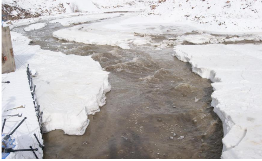
Şekil 6.35: Su alma yapısında gerçekleşen donma
