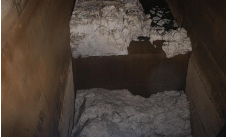
Şekil 6.37: İsale kanalında gerçekleşen donma
