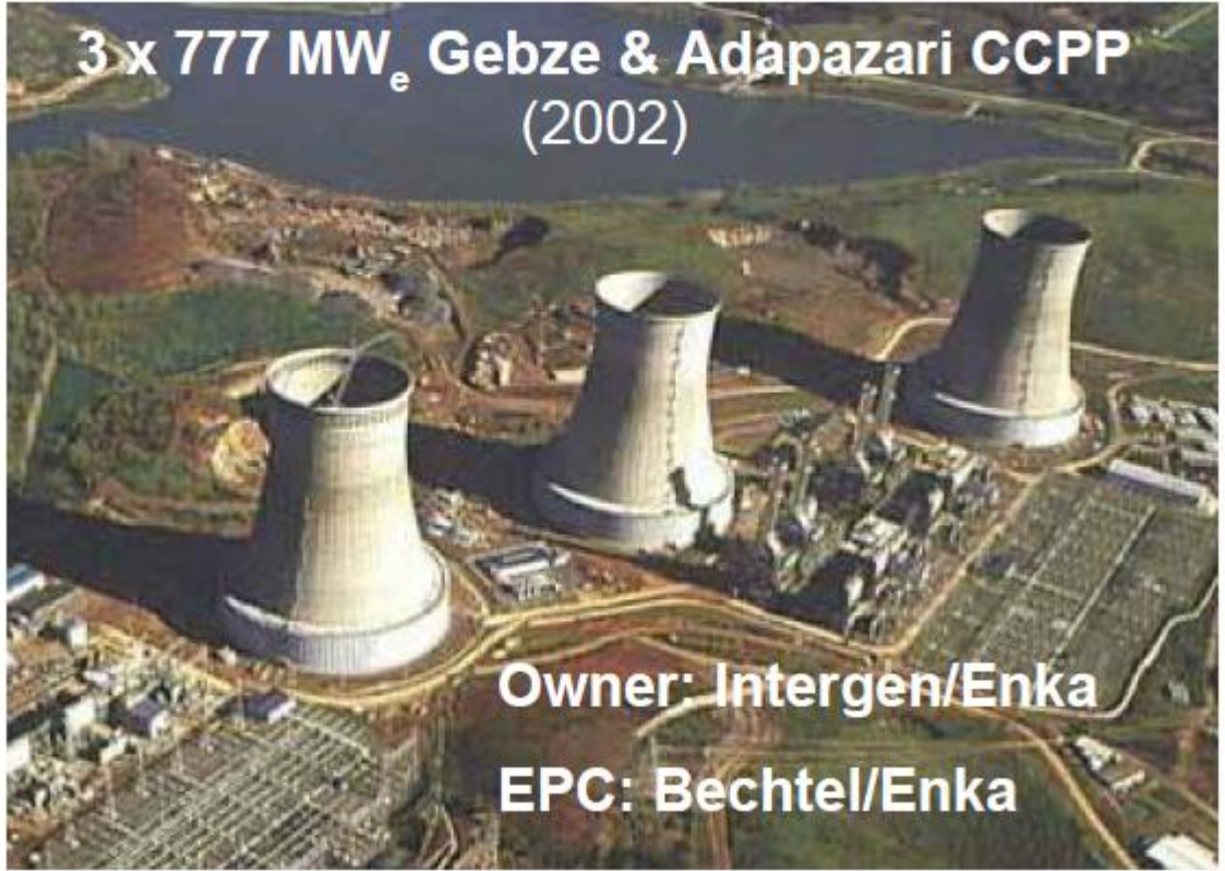
Şekil 2.11 : Gebze & Adapazari birleşik gaz buhar çevrim santralına ait Heller kuru tip soğutma kuleleri görüntüsü [9]
