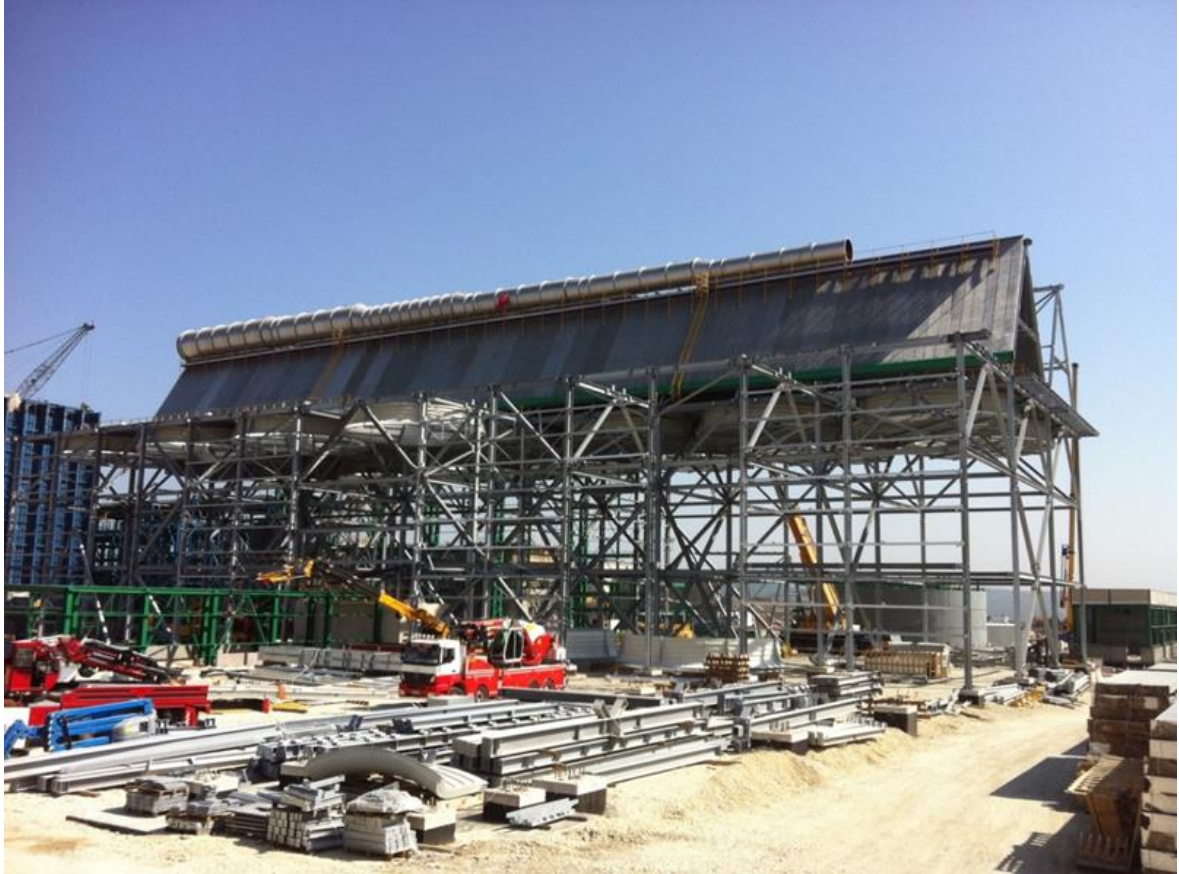
Şekil 4.4 : Boru demetlerinin montaj görüntüsü
