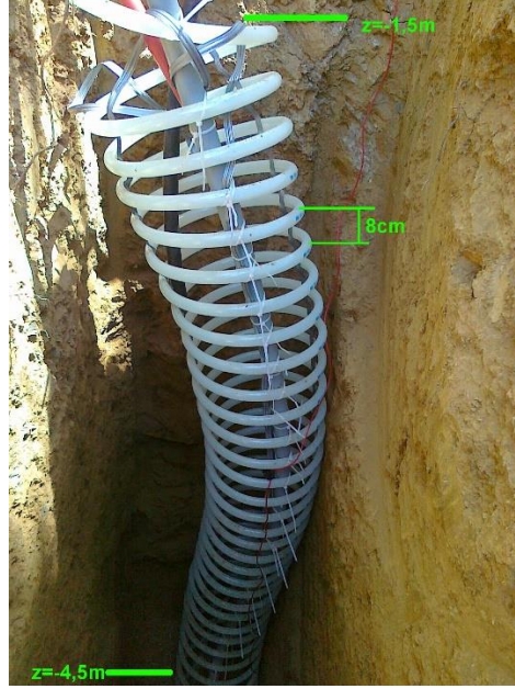
Şekil 3.4 : İTÜ Enerji Enstitüsü düşey helis kuyusu.
