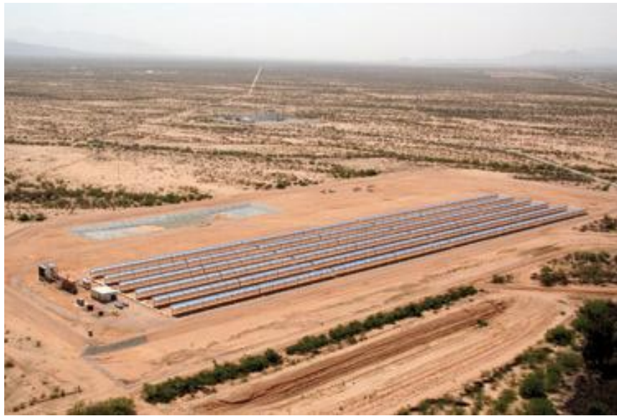
Şekil 2.1: Saguaro Güneş Enerjisi Santrali.
