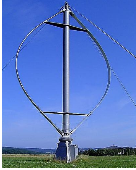
Şekil 2.15 : Klasik Darreius tipi rüzgar türbini
