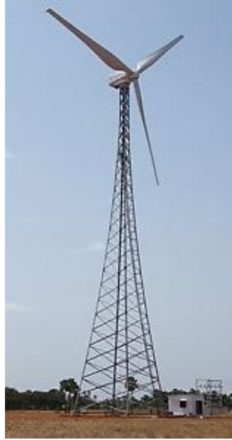
Şekil 2.19 : Çelik kafes tipi kule örneği
