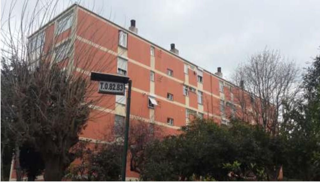
Şekil 1.6 : T.O. 82-83 blok 2. yan cephe.
