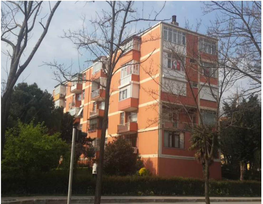
Şekil 1.5 : T.O. 82-83 blok 1. yan cephe.
