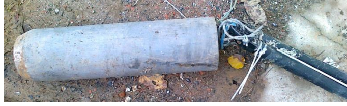
Şekil B.6: U borusunun kuyuya indirilmesi aşamasında kullanılan ağırlık.
