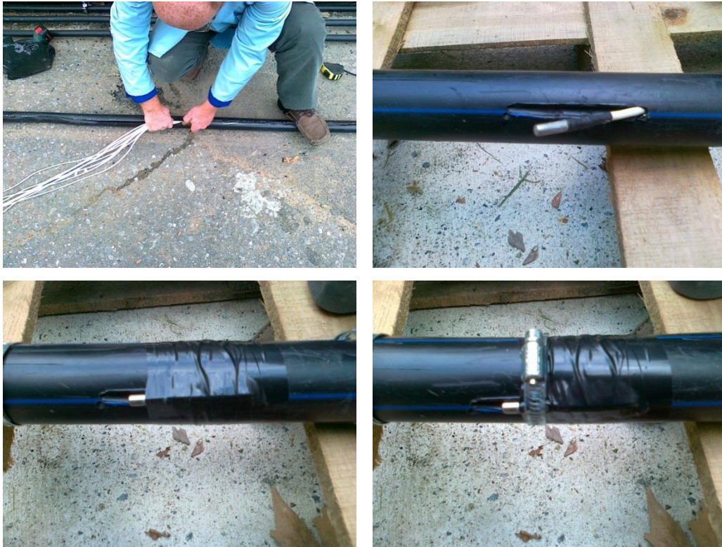
Şekil A.5: Kablo ve sensörlerin yerleştirilme aşamaları.
