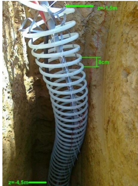
Şekil 4.3 : Düşey helisel tipi ısı değiştiricisi uygulaması.
