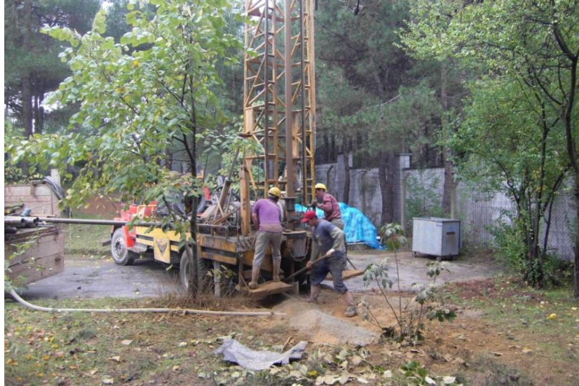
Şekil B.7: Kuyu açma işlemi.
