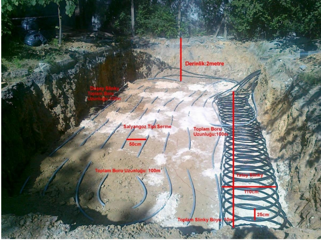
Şekil 4.2 : Sarmal, yatay ve düşey slinky ısı değiştiricisi uygulamaları.
