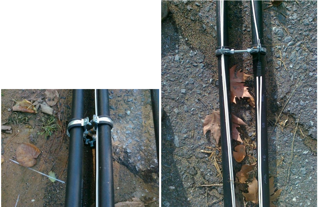
Şekil B.4: Kelepçelerin ve sensörlerin borulara tutturulmuş hali.
