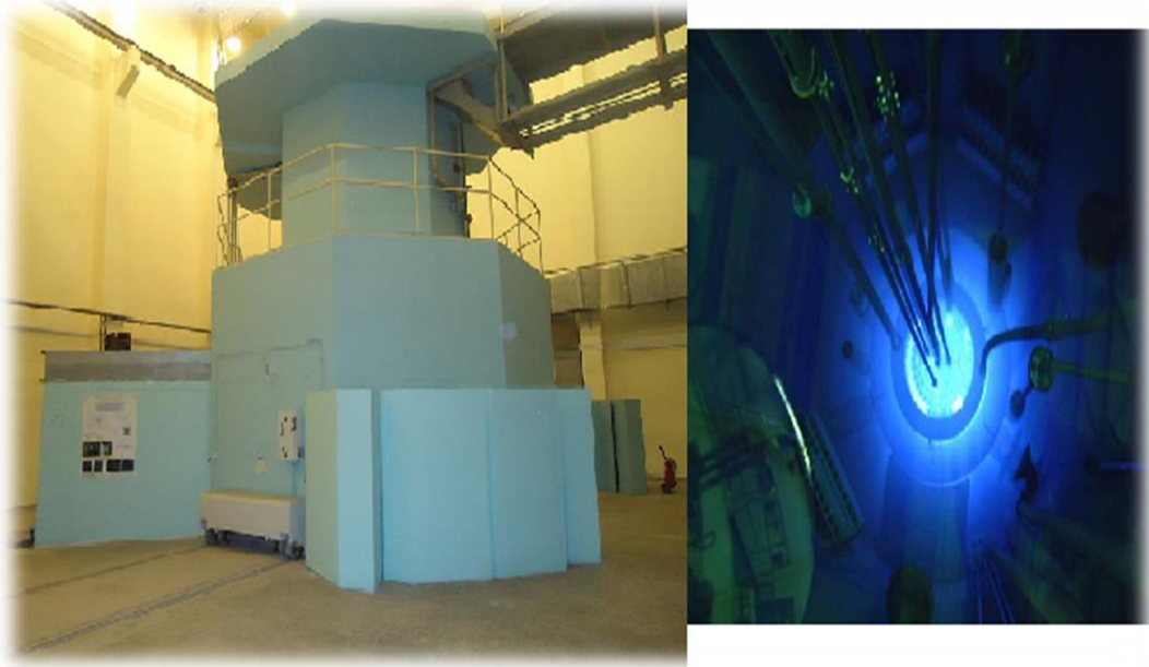
Şekil 5.2 : İTÜ TRIGA Mark-II eğitim ve araştırma reaktörü.
