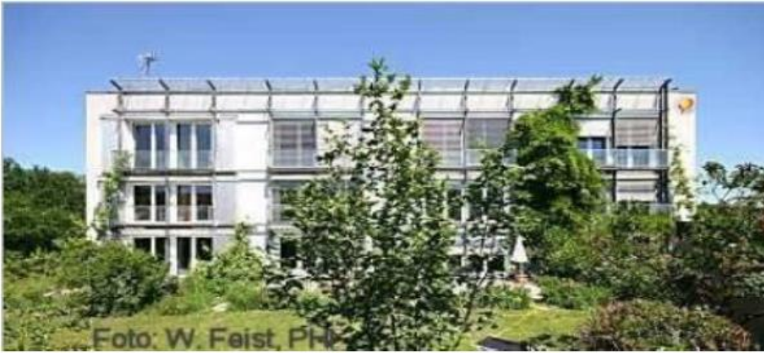
Şekil 2.10 : Darmstadt-Kranichstein'deki Passivhaus'un güney cephesi [29].
