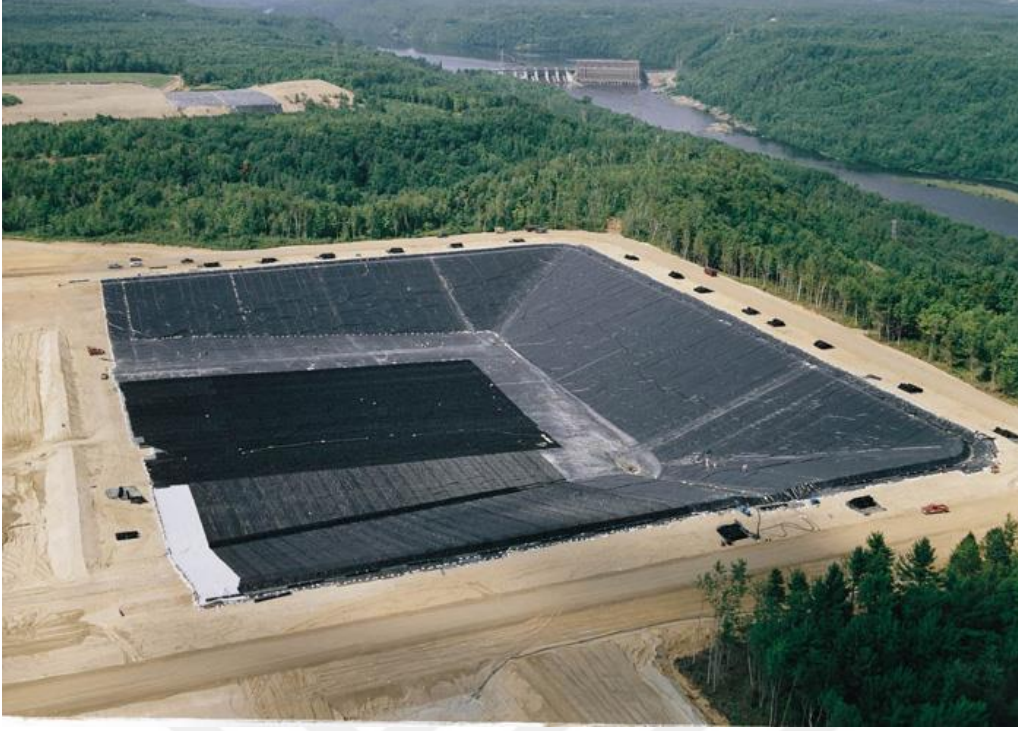
Şekil 3.5 : Şehir çöplüğü düzenli depolama sızdırmaz membranı [29].
