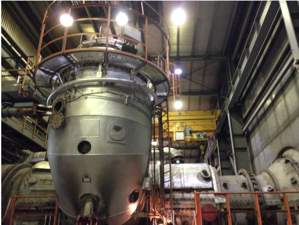
řekil 4.7 : Yanma odaları.
