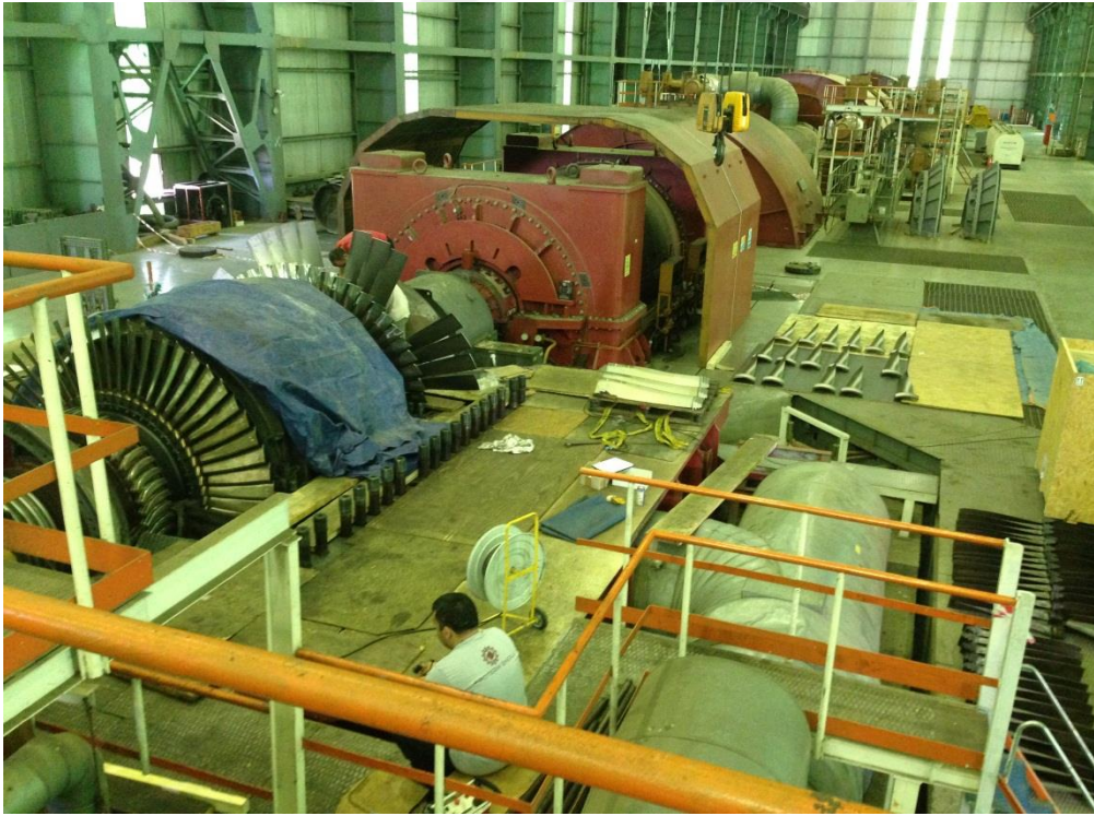
Şekil 4.11 :Buhar türbini ve generatörü.
