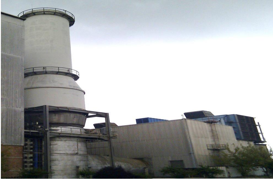
Şekil 4.9 :By-pass bacaları.
