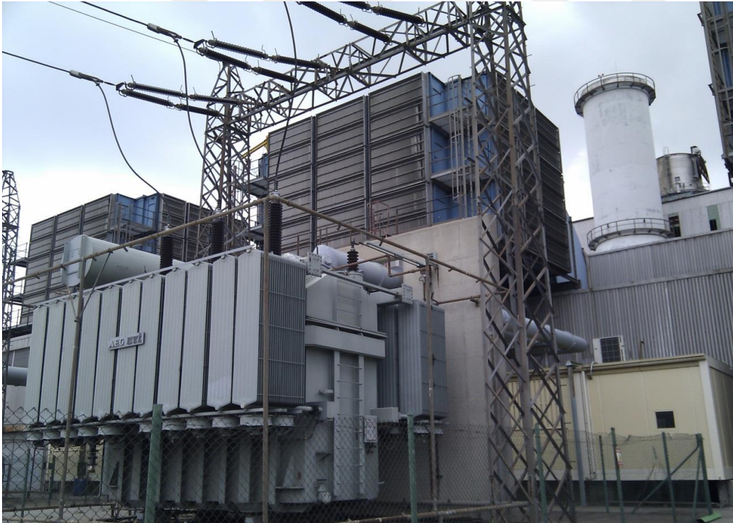
Őekil 4.5 :Gas trbini hava filtreleri.
