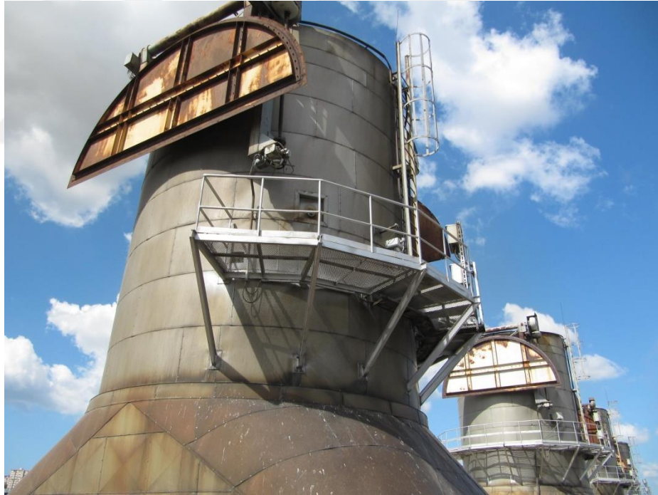
Şekil 4.10 :Atık ısı kazanları.
