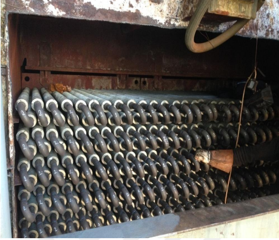
Şekil 6.13 :Değiştirilen atık ısı kazanı boruları.
