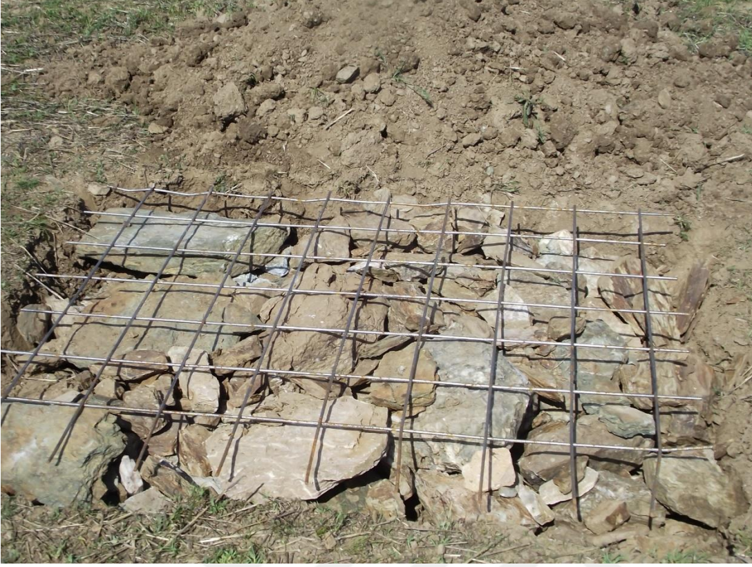
Şekil 3.14: Ölçüm direği temeli.
