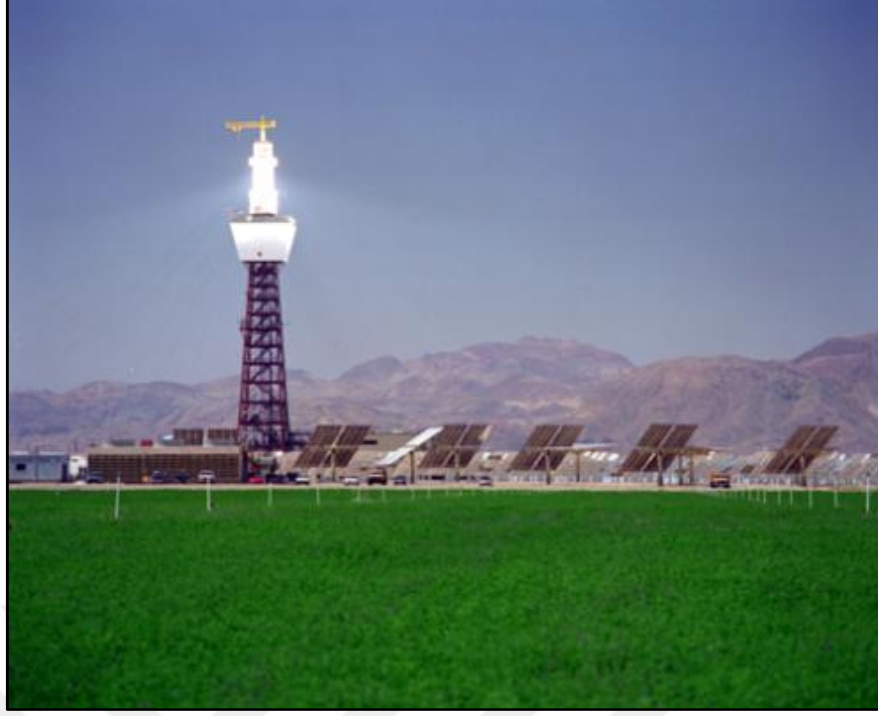
Şekil 1.45 : Güç kulesi sistemi örneği 2 [48].
