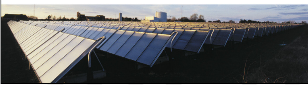
Şekil 1.49 : Danimarka’da evlerin sıcak kullanım ihtiyacını karşılamak üzere kurulmuş ısıtıl güneş enerjisi sistemi örneği [61].
