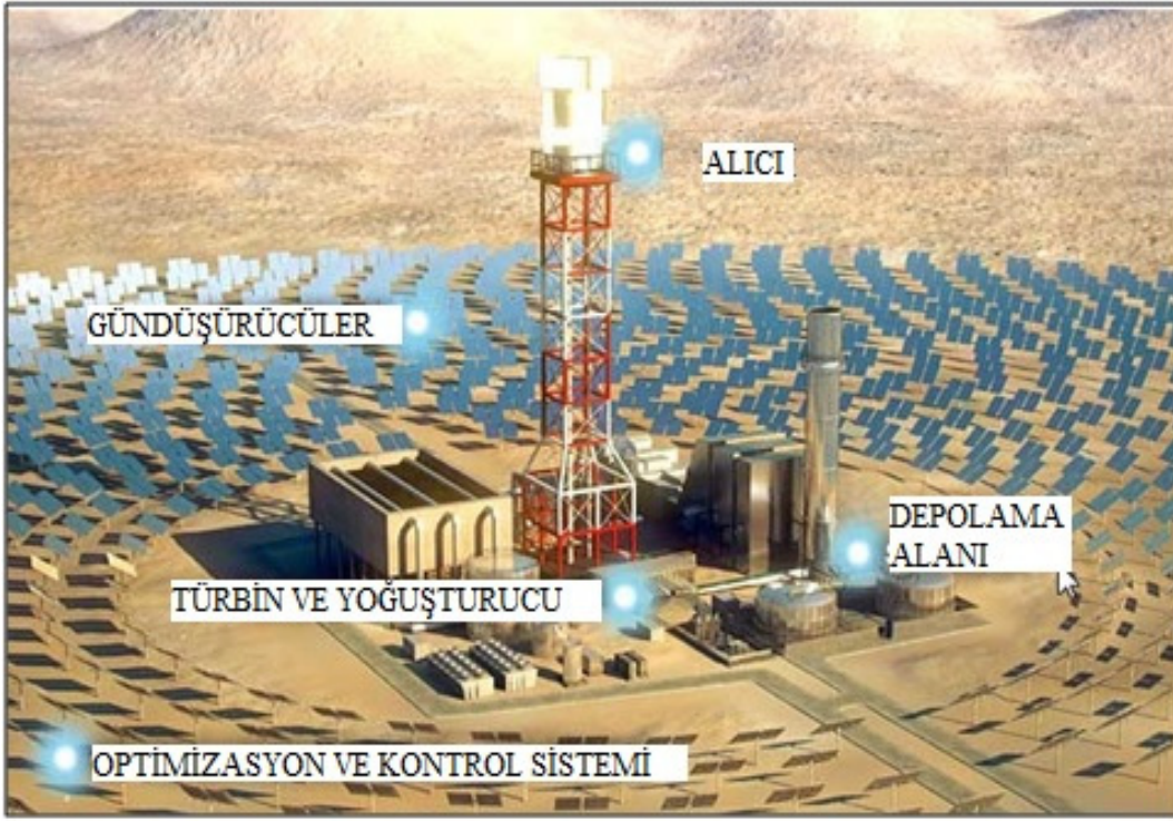
Şekil 1.43 : Güç kulesi sistemi örneği 1 [50].
