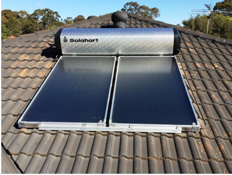
Şekil 1.14 : Türkiye’de yaygın kullanılan pasif güneş enerjisi su ısıtma sistemi örneği [21].
