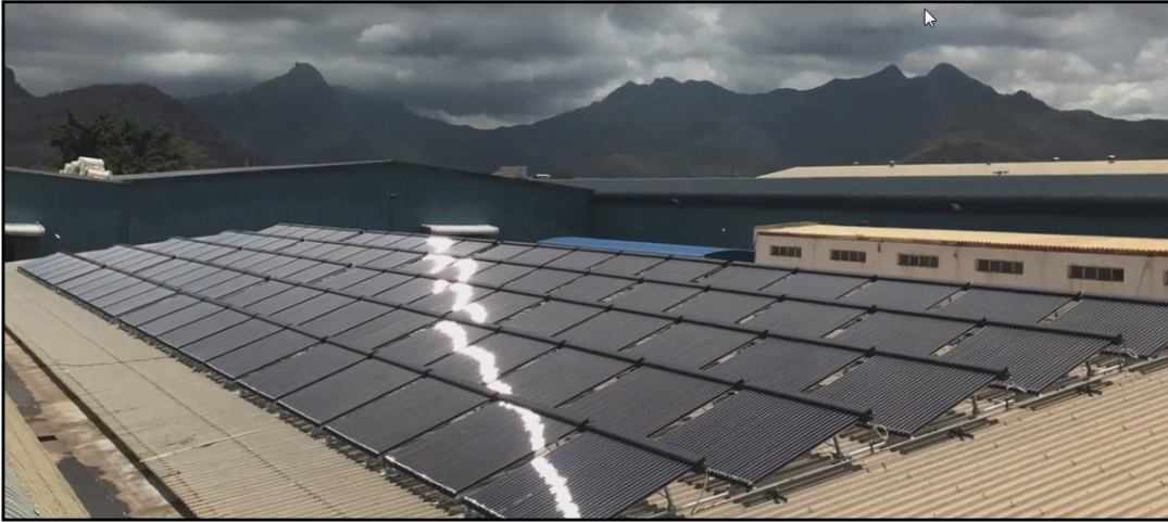
Şekil 1.50 : Mauritius, Kumaş Boyama fabrikası proseslerinde kullanılacak sıcak suyun karşılanmasına yönelik kurulan ısıtıl güneş sistemi örneği [62].
