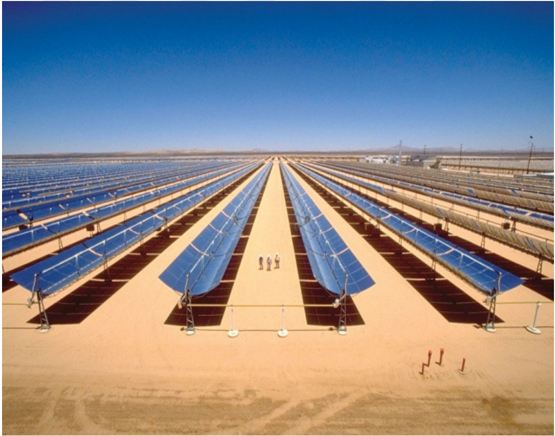
Şekil 1.39 : Parabolik oluk kolektörlü güneş enerjisi sistemi [45].
