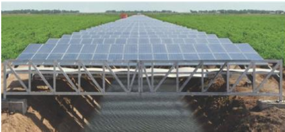
Şekil 3.20: Kanal üstü fotovoltaik sistem örneği.
