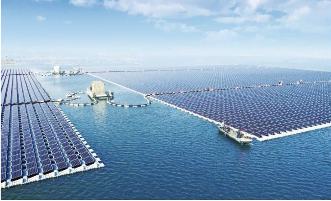
Şekil 4.5: Solar evirici ve elektrik ekipmanlarının yüzdürüldüğü sistem örneği.
