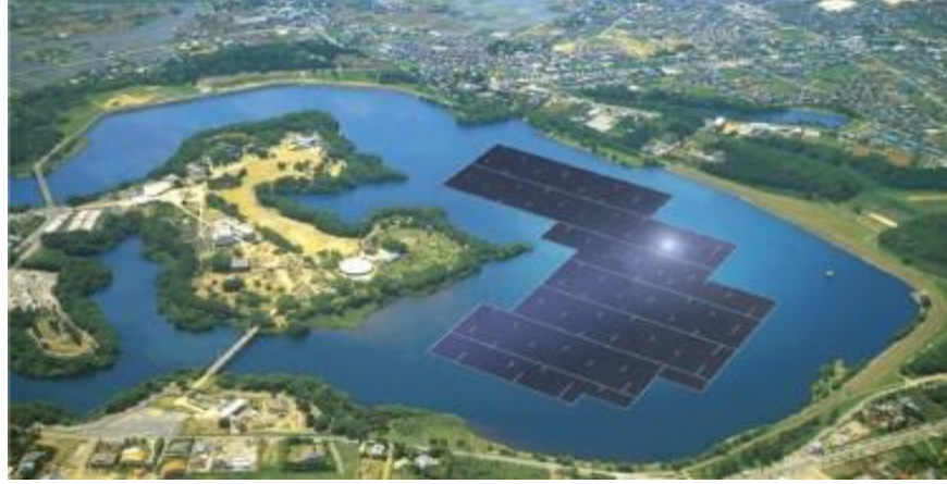
Şekil 3.22: Yüzer fotovoltaik sistem örneği.
