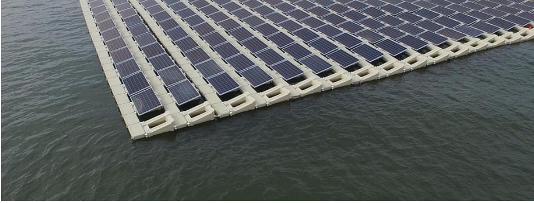
Şekil 4.1: Gerçek bir yüzer FV sistemden yüzdürücü sistem tasarımı örneği.
