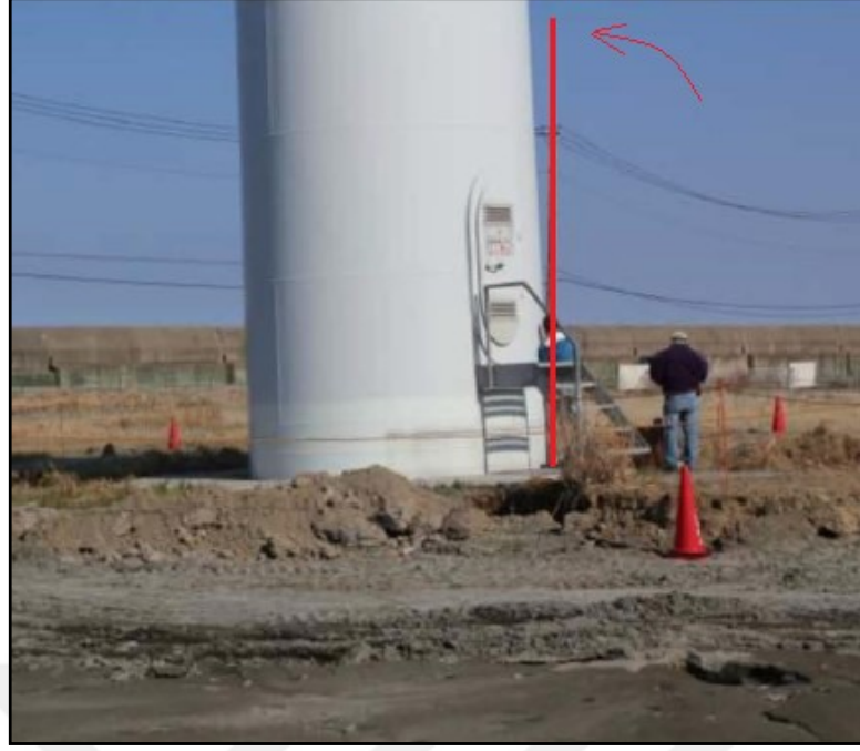
Şekil 4.8 : Japonya Summit Santrali, depremden dolayı yaşanan hasar [41].
