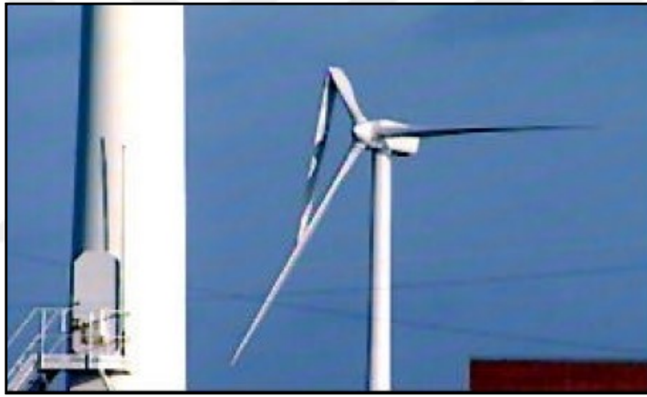
Şekil 4.11 : İngiltere Blyth Harbour Denizaşırı Rüzgar Santrali'nde yıldırımdan dolayı yaşanan hasar [47].
