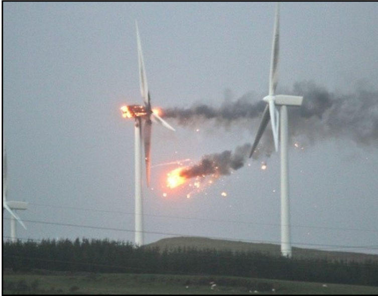
Şekil 4.10 : Ardrossan Rüzgar Santrali kasırga hasarı [45].
