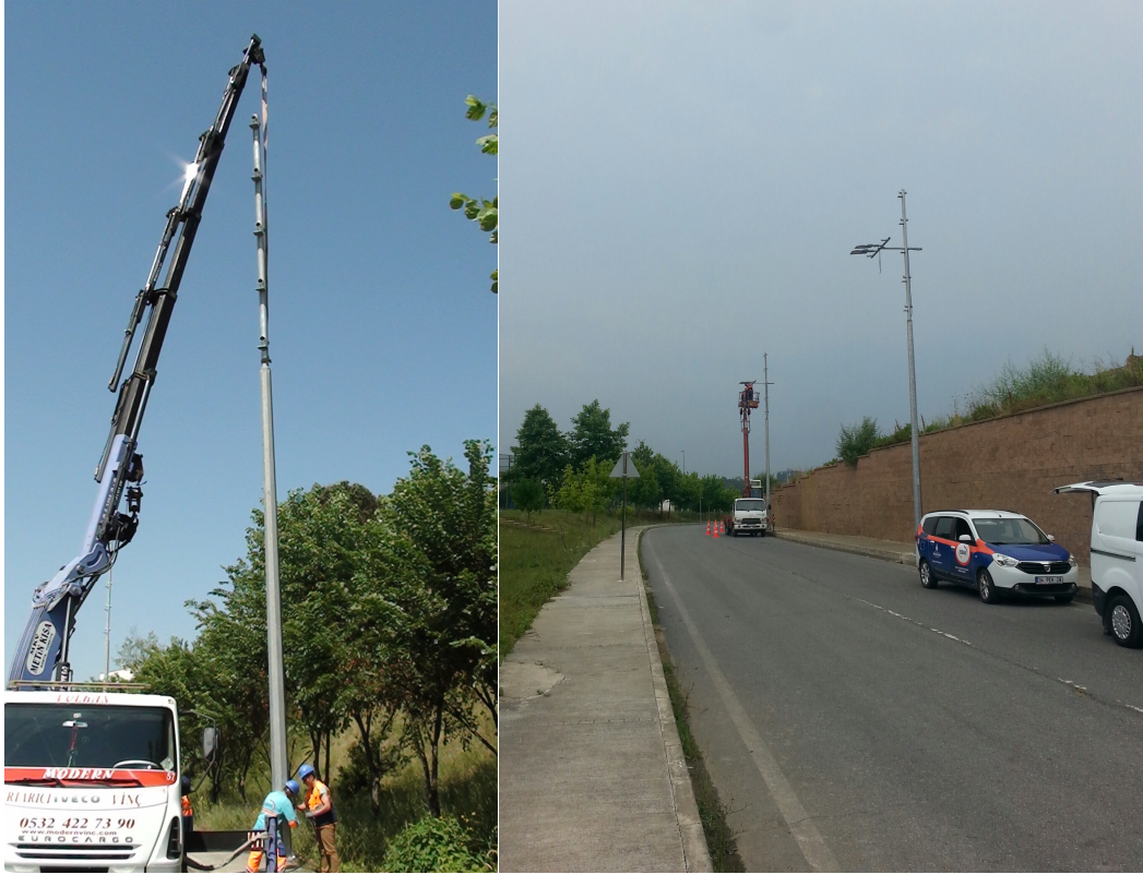
Şekil 2.3 : Direklerin sahaya yerleştirilmesi ve armatür montajı.
