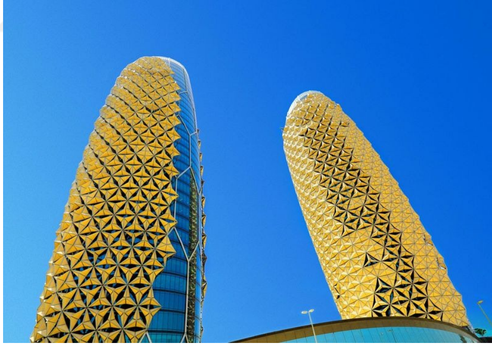
Şekil 3.17 : Abu Dhabi Bahar Towers'daki çalışması cepheye kurulmuş olan fotovoltaik paneller vasıtası ile karşılanan yenilikçi dış gölgeleme sistemi.
