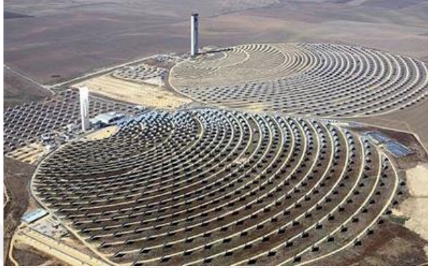
Şekil 2.16 : Merkezi alıcı sistemlerden oluşan bir güneş enerji santrali (Url-4).
