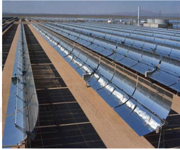
Şekil 2.14 : Parabolik oluk kolektörlerinden oluşan bir güneş enerji santrali (Url-8).
