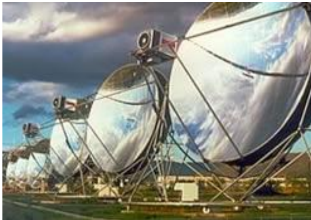
Şekil 2.15 : Parabolik çanak kolektörlerinden oluşan bir güneş enerji santrali (Url-9).
