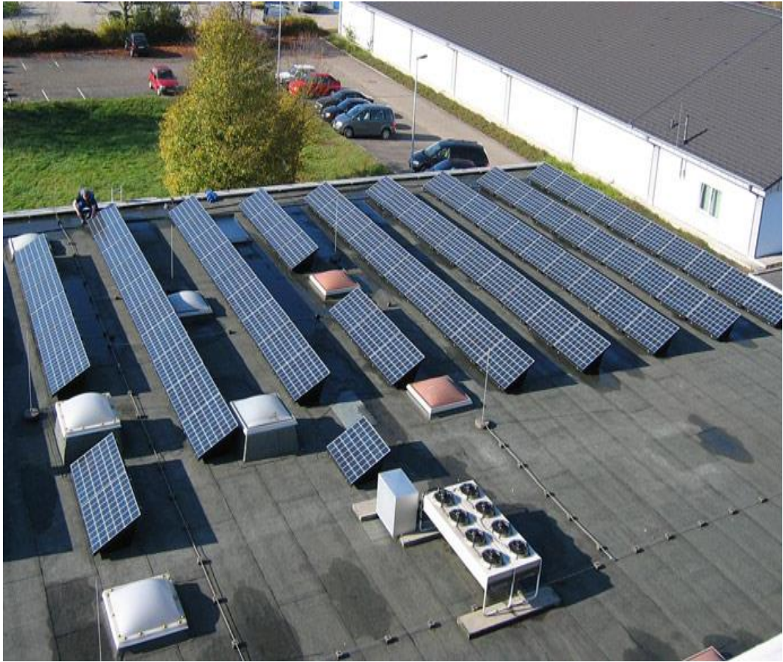
Şekil 3.2 : Düz çatı üzerine kurulu bir FV sistem.
