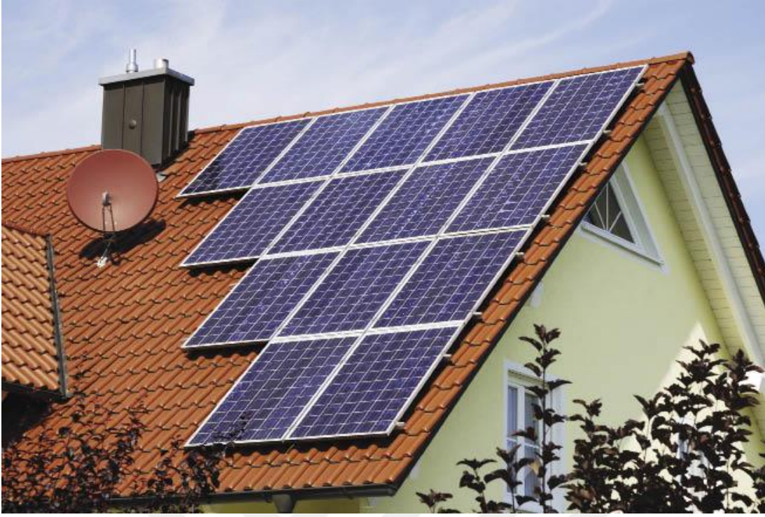
Şekil 3.3 : Eğimli çatı üzerine sonradan monte edilmiş bir FV sistem [85].
