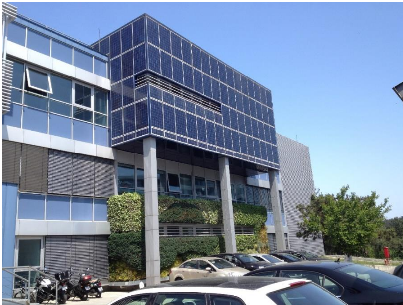
Şekil 1.15 : Arı 6 Enerji Teknokent binasındaki BIPV sistem.
