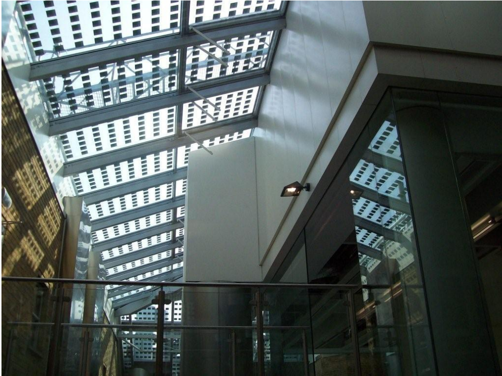
Şekil 3.6 : Atriumda FV sistem kullanımı örneği.
