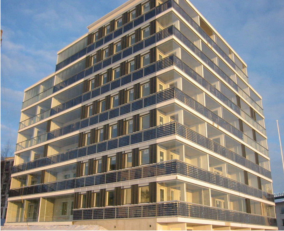
Şekil 3.8 : Balkon korkuluđu olarak FV sistem kullanılması.
