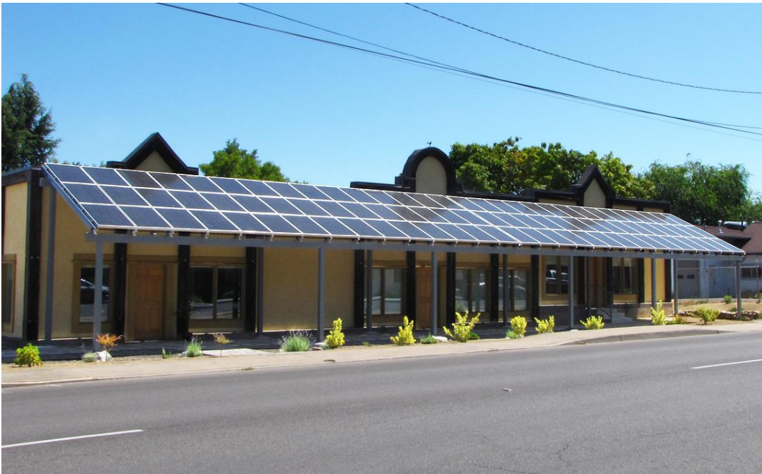
Şekil 3.9 : Gölgelik olarak kullanılan FV sistem örneđi.
