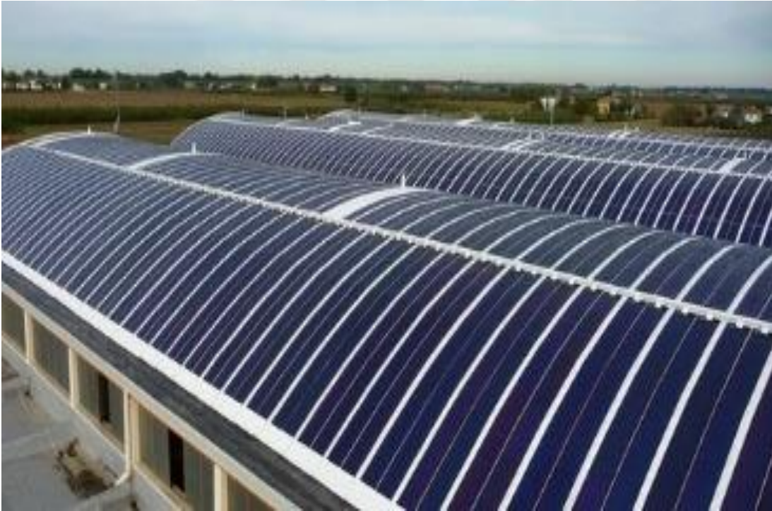
Şekil 3.4 : Eğrisel çatı üzerine kurulu FV sistem [86].
