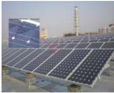
Şekil 4.4 : Fotovoltaik panellerde gözlenen salyangoz izi lekesi [63].
