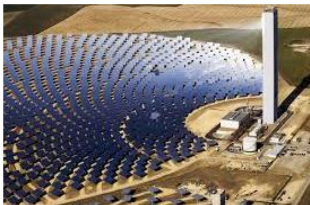
Figure 1.3 : Tower system (Kaushika et al., 2000).
