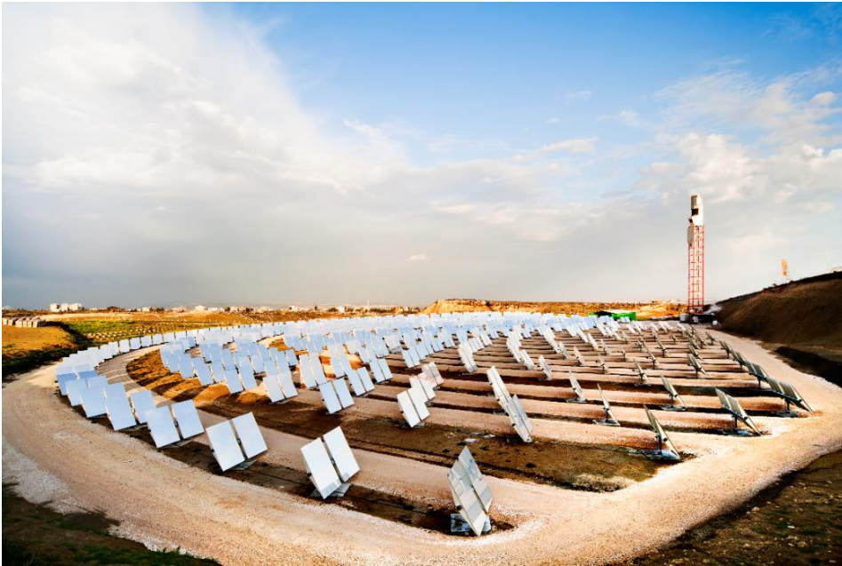
Şekil 2.1: Kule tipi konsantre güneş enerjisi santrali [5].
