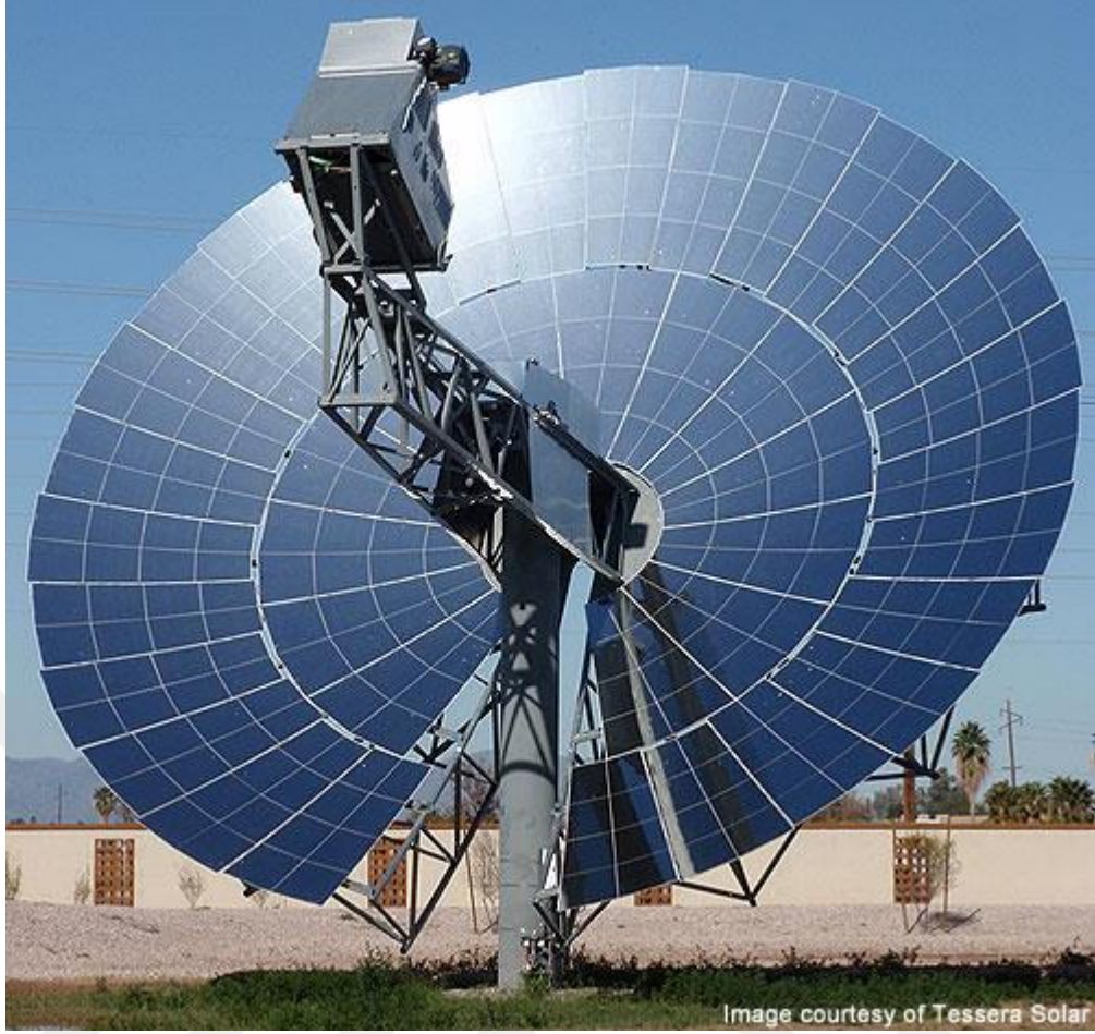
Şekil 2.4: Maricopa santralindeki parabolik çanak tipi kolektör [9].
