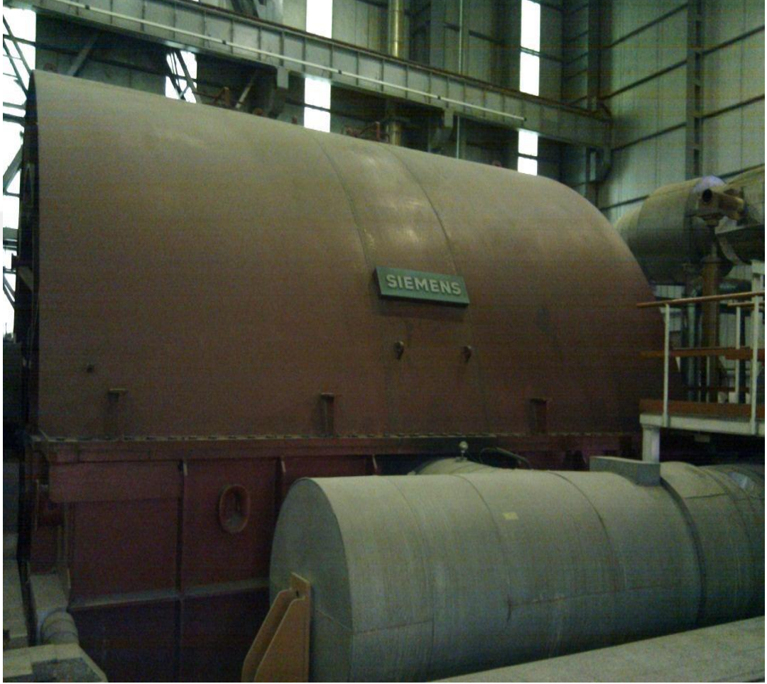
Şekil 2.8 : Buhar türbini grubu.
