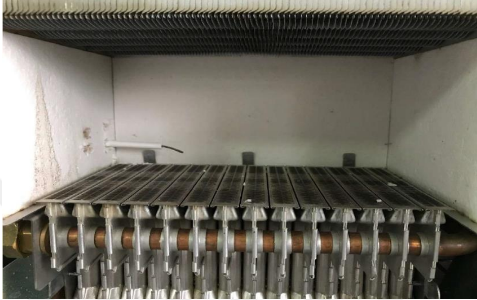
Şekil 4.16 : Yanma odası iyonizasyon elektrotu konumlandırması.
