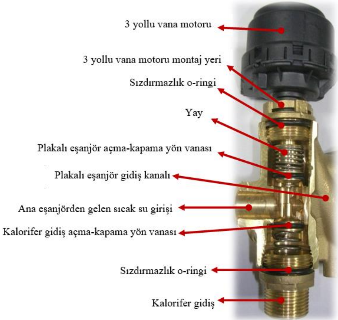
Şekil 2.18 : Üç yollu vana motoru ve parçaları [16].
