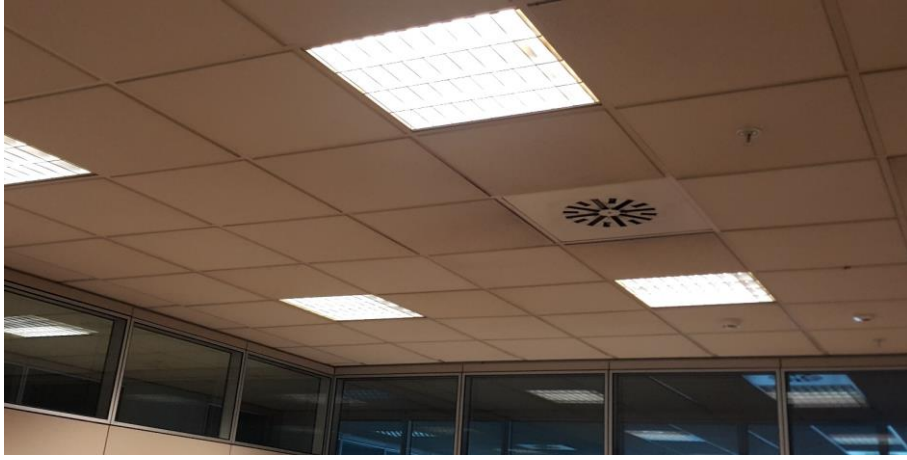
Şekil 7. 10 : 4x18 W flüoresan lambalı çift parabolik reflektörlü kare armatürler ile aydınlatılmış hacim.
