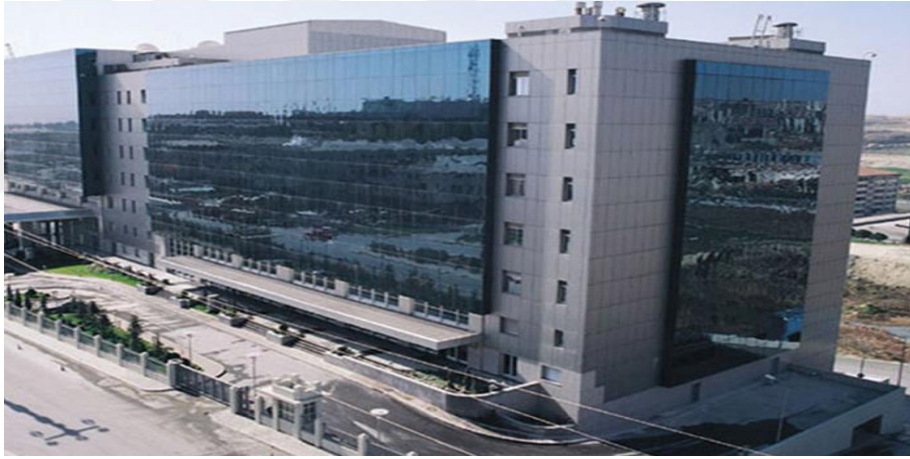
Şekil 7. 7 : Tez kapsamında incelenen bina.
