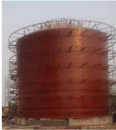
Şekil 1.27 : Sezonluk Depolama Sıcak Su Deposunun Toprak Altına Montajı Öncesi [29].
