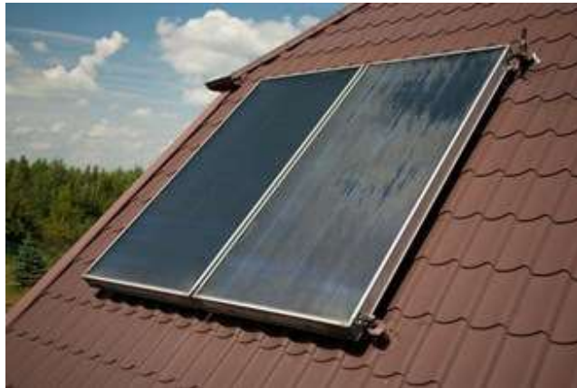
Şekil 1.10 : Düzlemsel Kolektörün Çatı Montajı Örneği[11].
