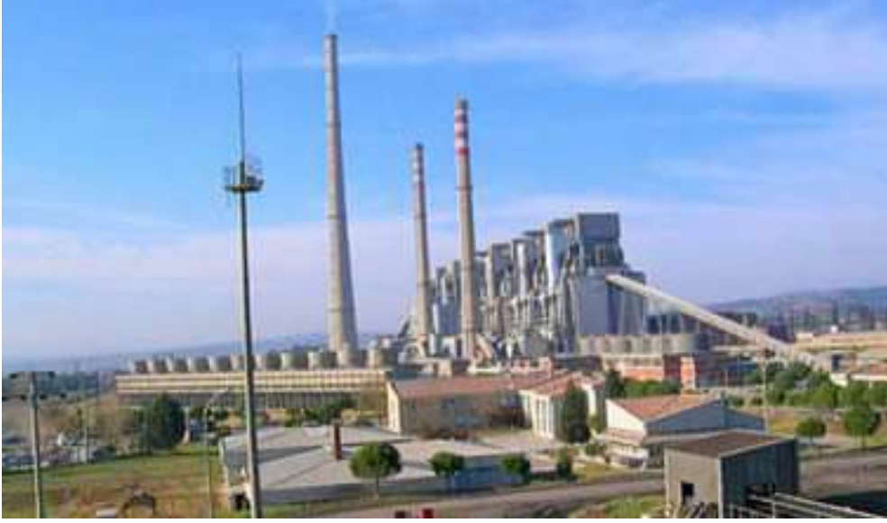
Şekil 1.45 : Soma Termik Santrali[69].
