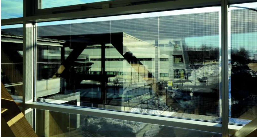
Şekil 1.5: Transparan FV modül ile BIPV uygulaması.
