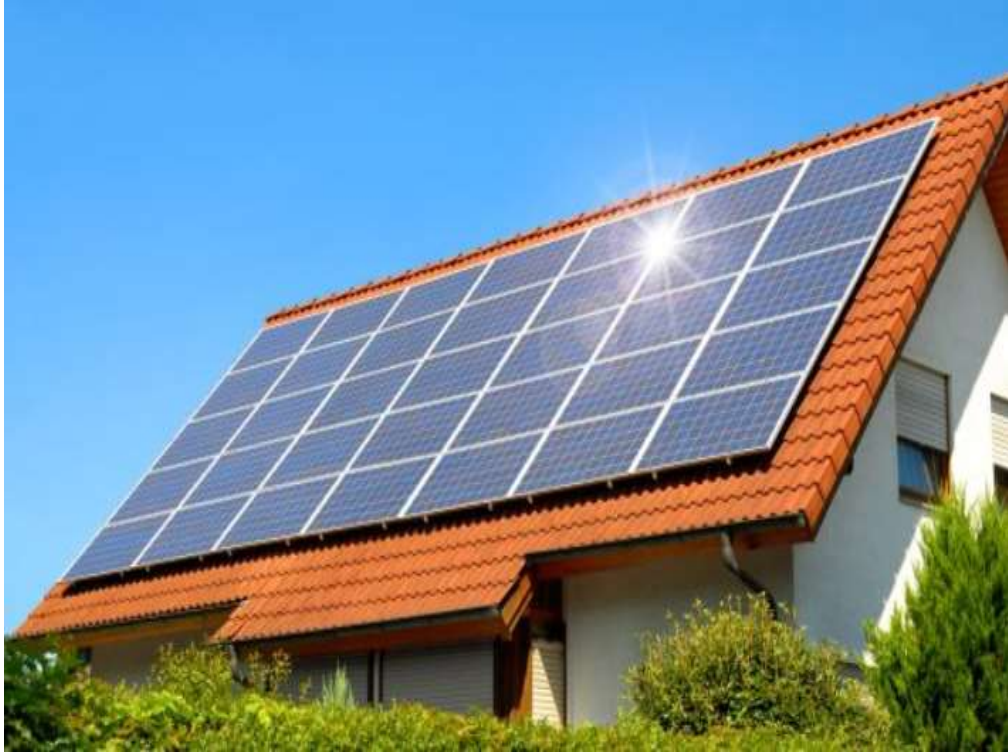
Şekil 5.11: Kurulum (A)'ya örnek BAPV uygulaması.
