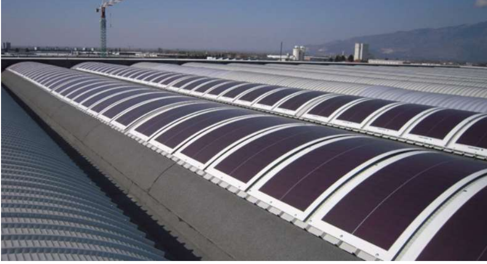
Şekil 1.3: Esnek FV modül ile BIPV uygulaması.
