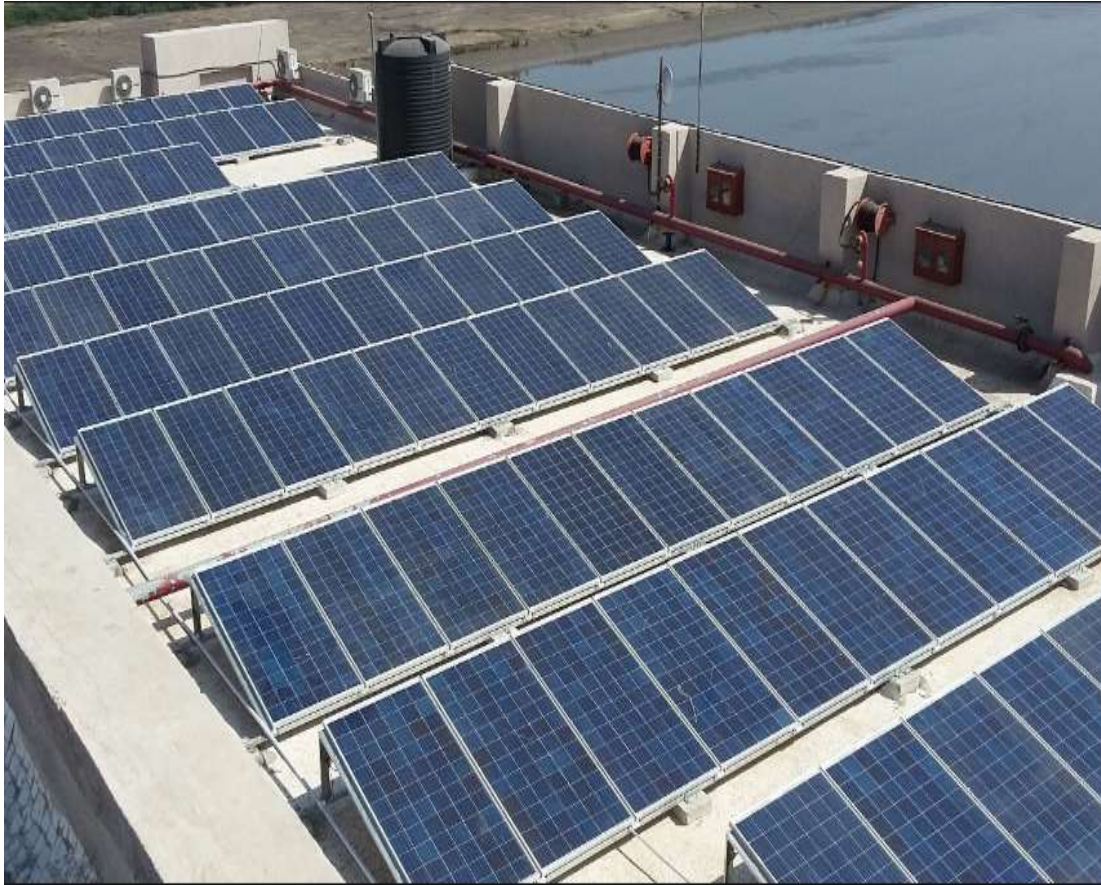
Şekil 5.9: Kurulum (B)'ye örnek BAPV uygulaması.
