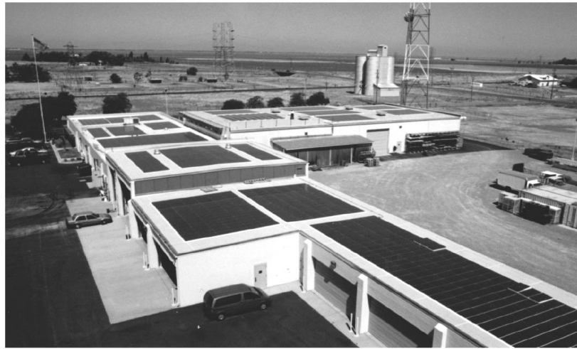
Şekil 5.3: U.S. batı bölgesi güç yönetimi enerji binası.
