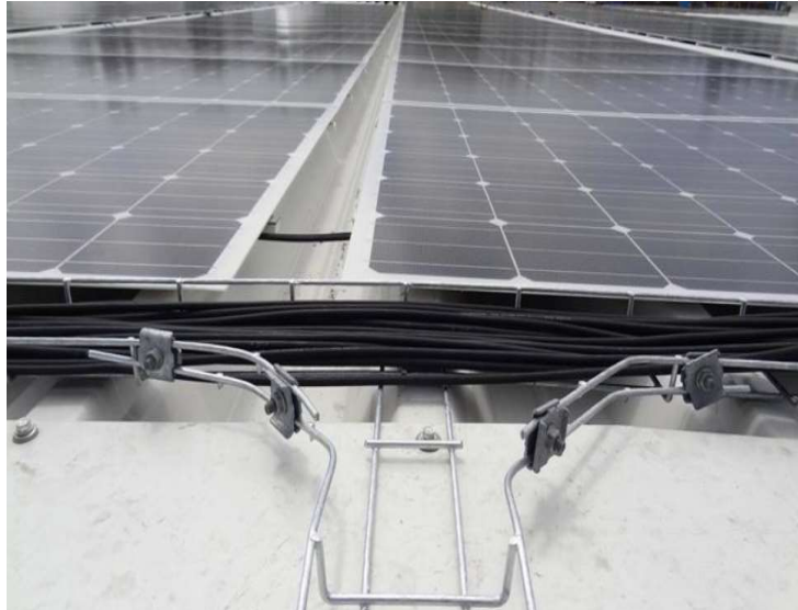
Şekil 2.19: Kablo kanalı kullanımı [22].
