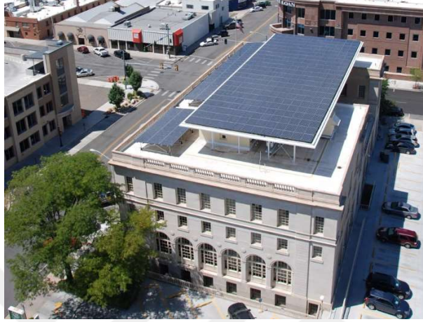
Şekil 1.2: Standart FV modül ile BIPV uygulaması.
