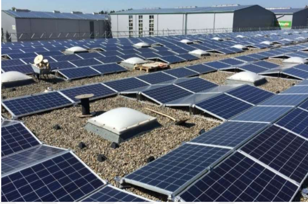
Şekil 5.10: Kurulum (C)'ye örnek BAPV uygulaması.
