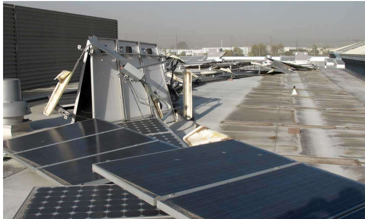
Şekil 2.17: Kötü FV modül montajına örnek.
