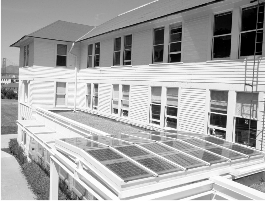
Şekil 5.4: Presidio milli parkı çatısındaki BIPV uygulaması.
