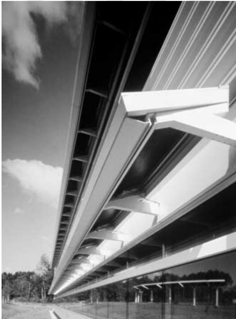
Şekil 5.7: State University of New York binası.
