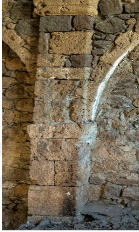
Şekil 3.28 Kemerlerin Oturduğu Sütunda Malzeme Kullanımı
