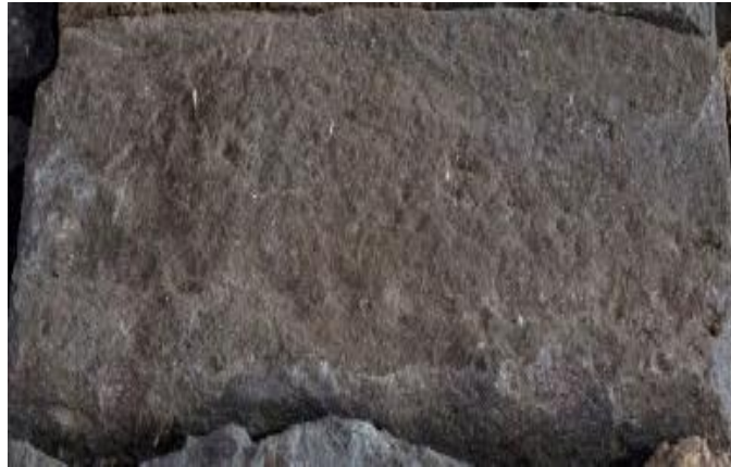
Şekil 3.14 Yapıda Kullanılan Andezit Taş Örneği
