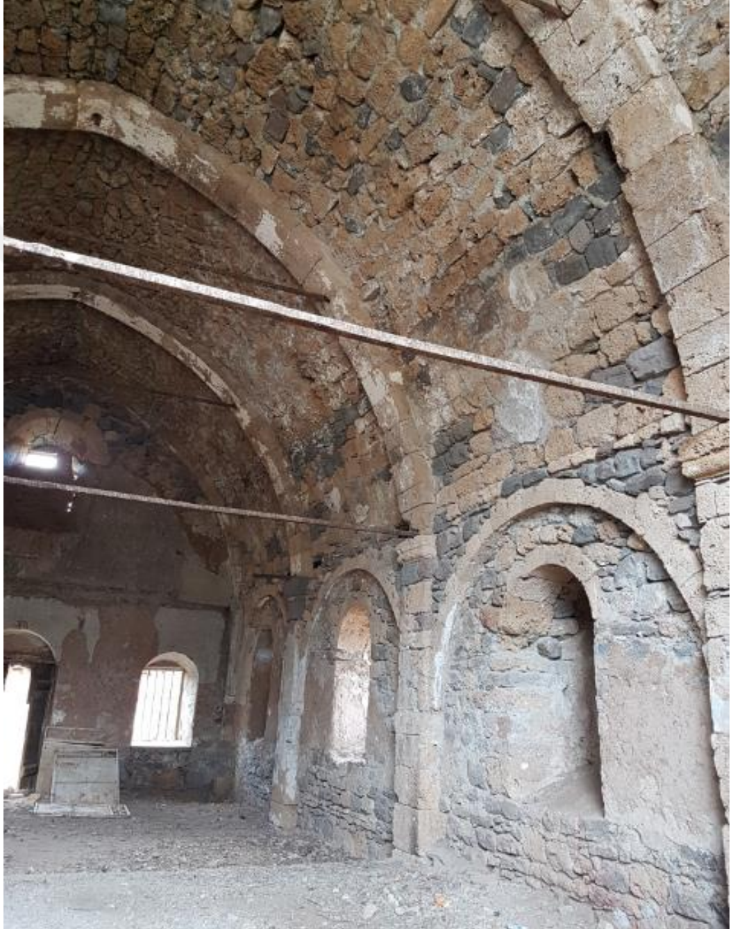
Şekil 3.6. Kilise Yapısında Kesme Taş ve Moloz Taş Kullanım Örnekleri
