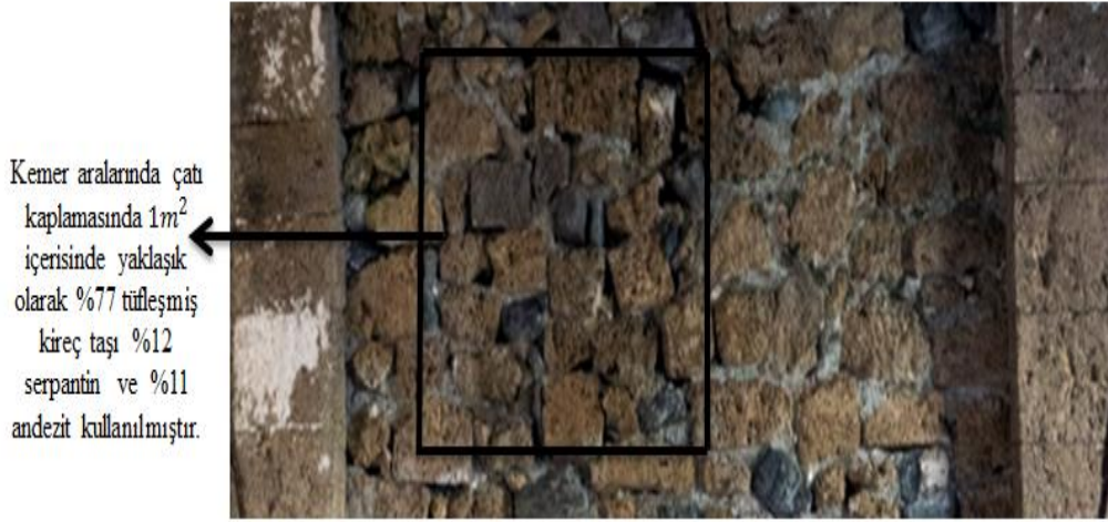
Şekil 3.25 Çatı Kaplamasında Kullanılan Malzeme Birleşenleri
