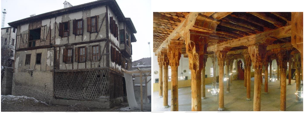
Şekil 3.8. Ahşap malzemeli tarihi yapılar
