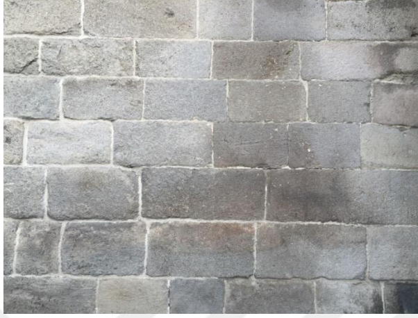
Şekil 4.10a. Yakutiye Medresesi duvarlarından bir görüntü
