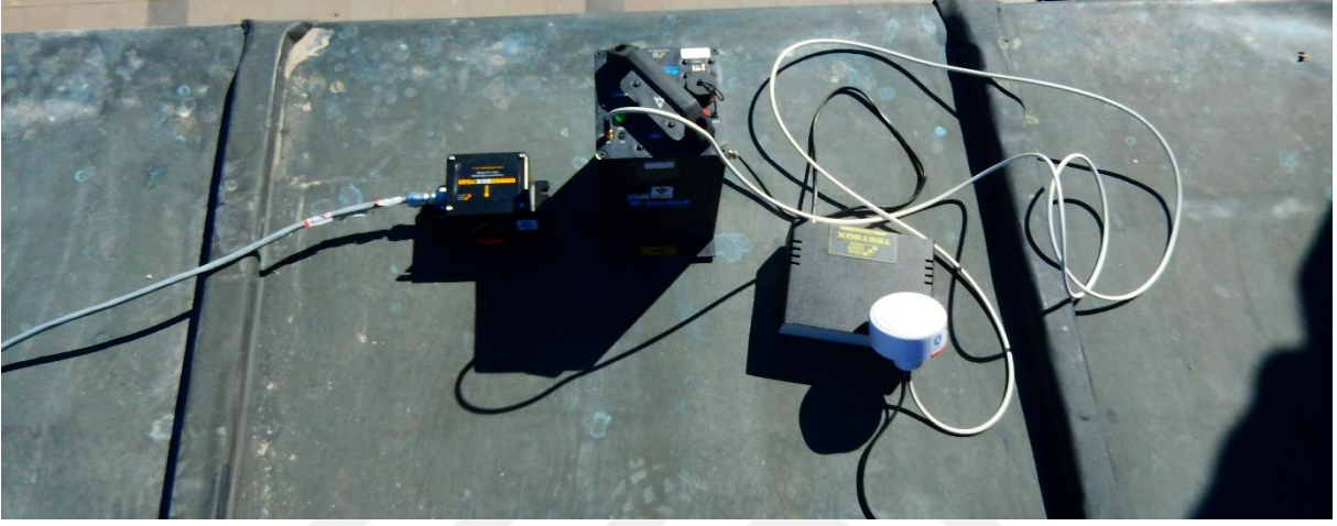
Şekil 4.16. Kablolu ve kablosuz ölçüm düzenleri arasındaki bağlantıyı sağlayan referans ivmeölçer kurulumu
