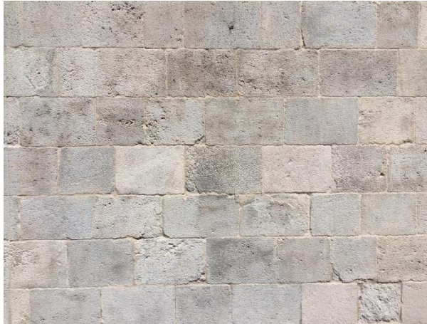
Şekil 4.11a. Lala Paşa Cami duvarlarından bir görüntü
